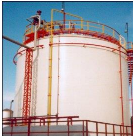
Ilustración 4 - Tanque de Almacenamiento de Petróleo
