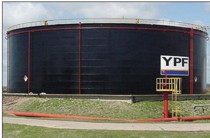
Ilustración 3 - Tanque de Almacenamiento de Petróleo
