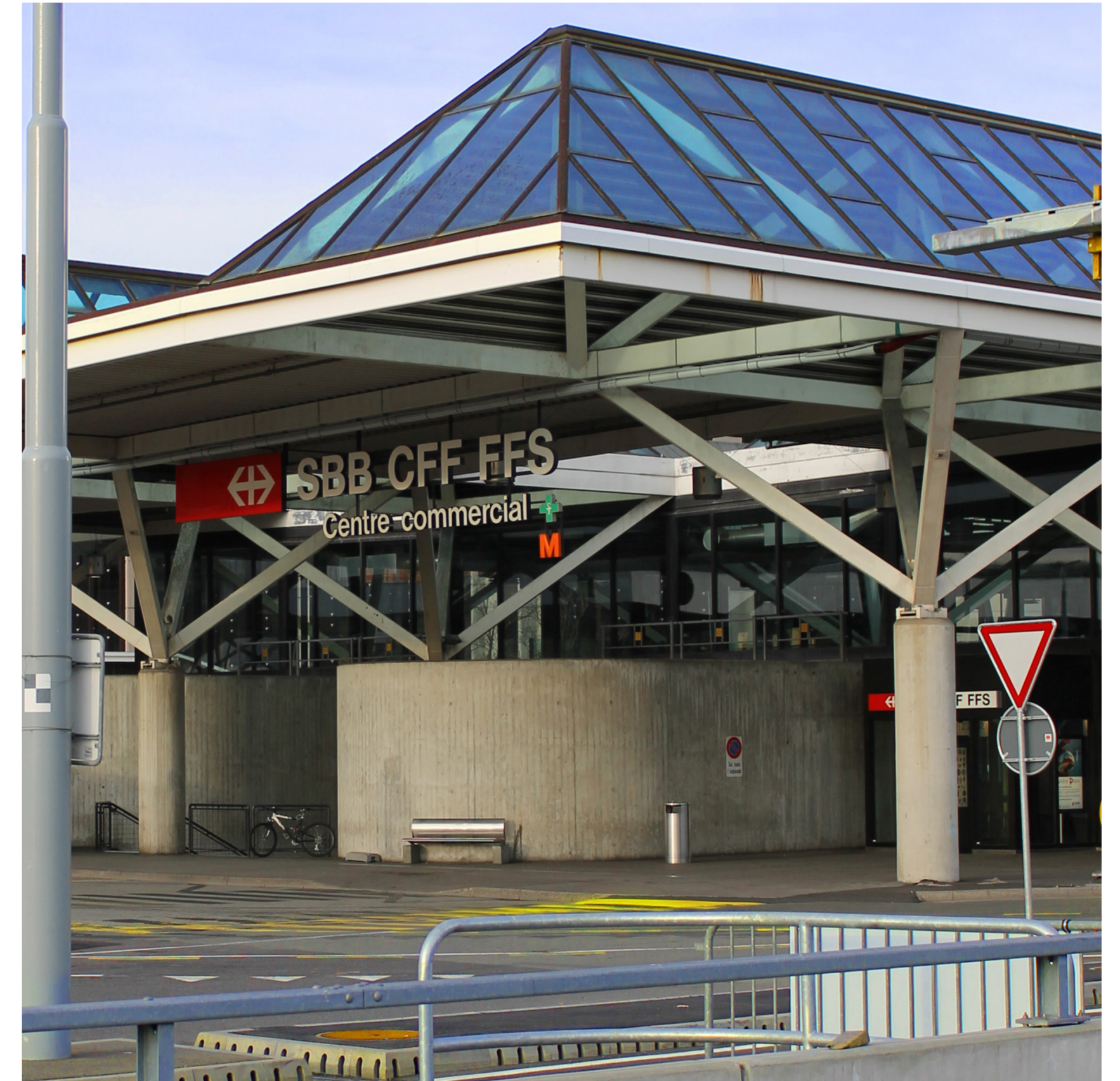
Perspectiva exterior. Geneva International Airport. Fuente: www.gva.ch
