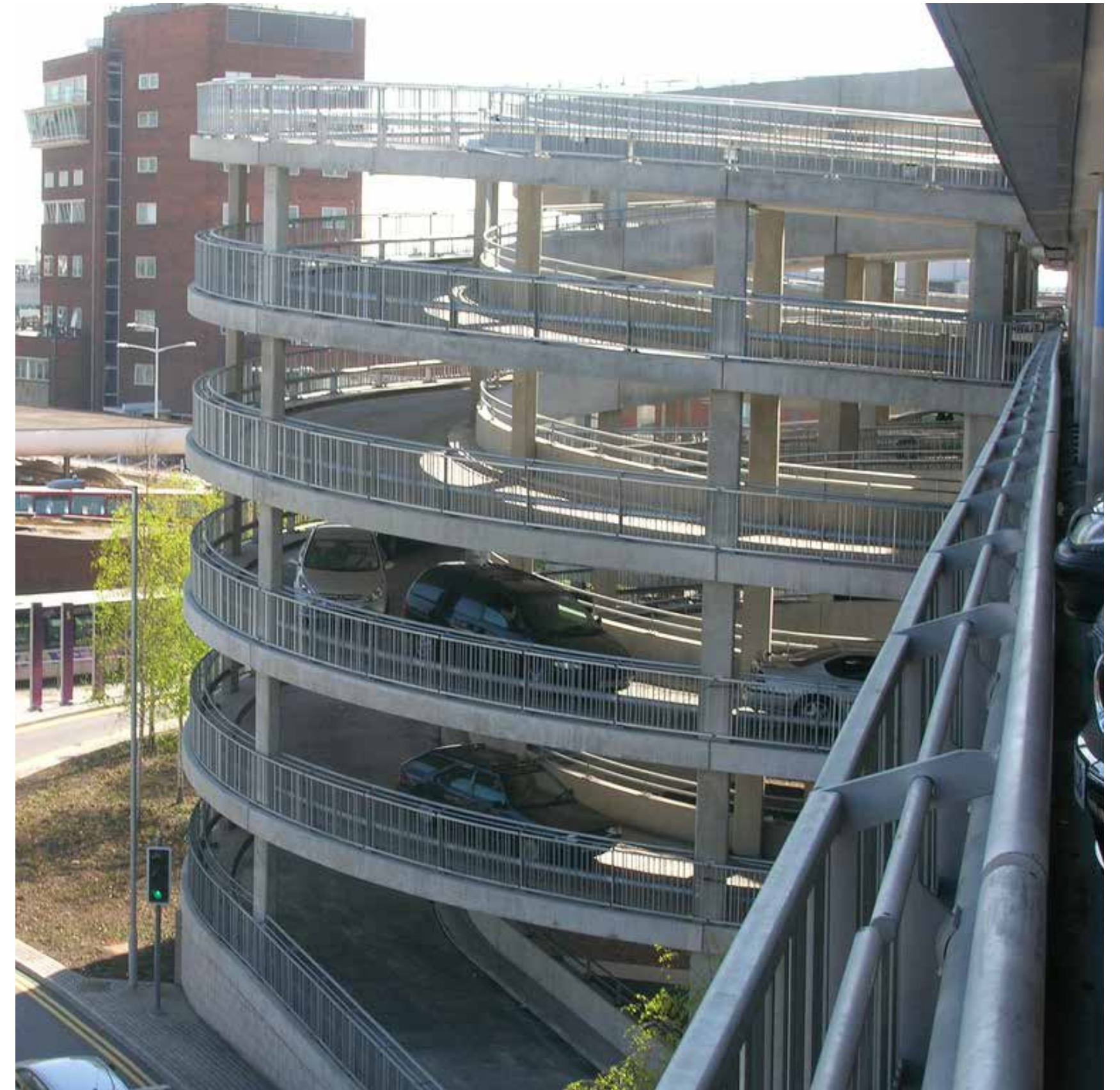
Imagen exterior. Heathrow. Rampa helicoidal del estacionamiento multinivel
