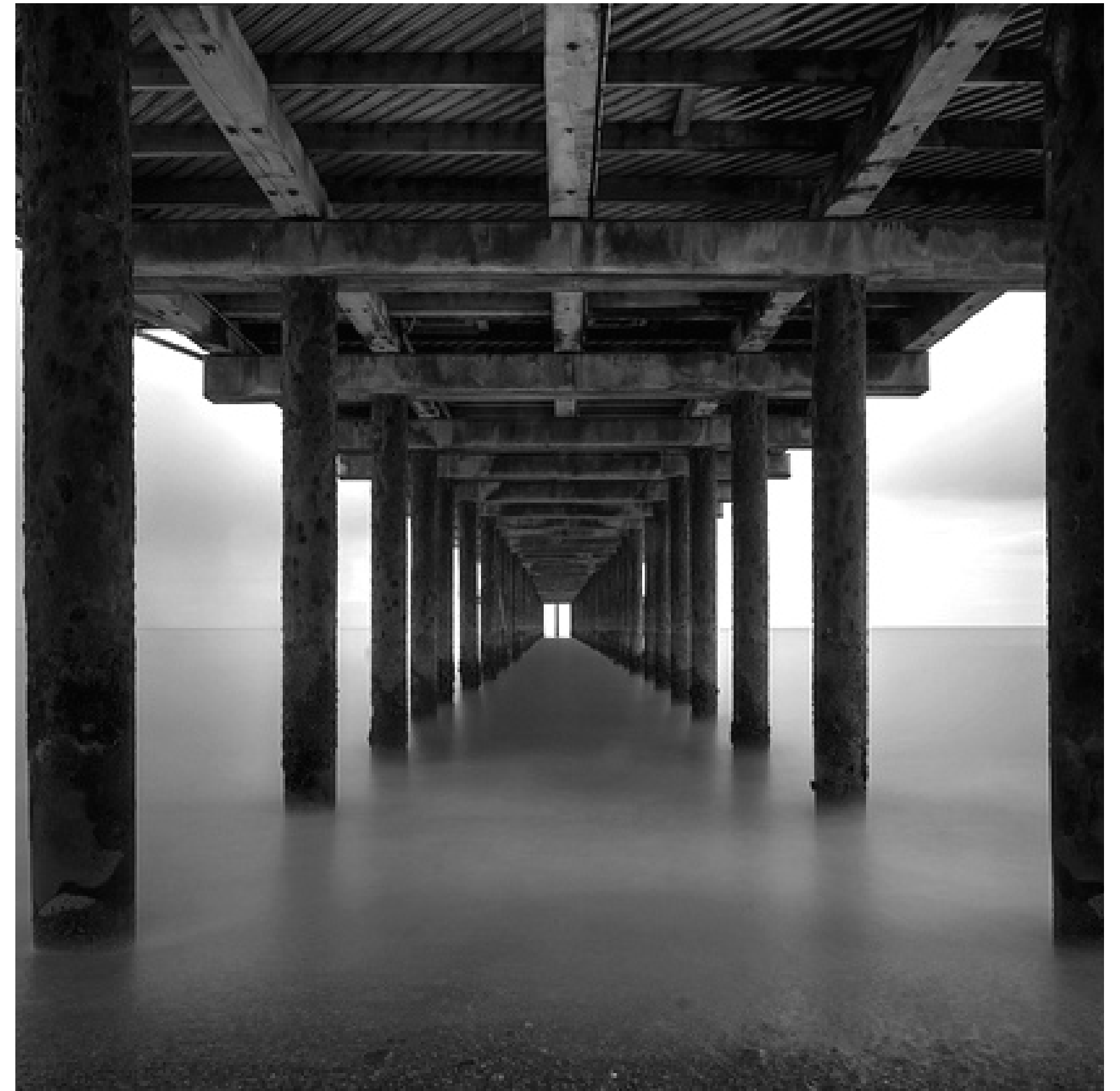
Imagen exterior. Estructura de muelle de pilares de hormigón, alineados hacia los bordes del muelle, sobre los cuales apoyan vigas transversales que sostienen vigas longitudinales y una losa
