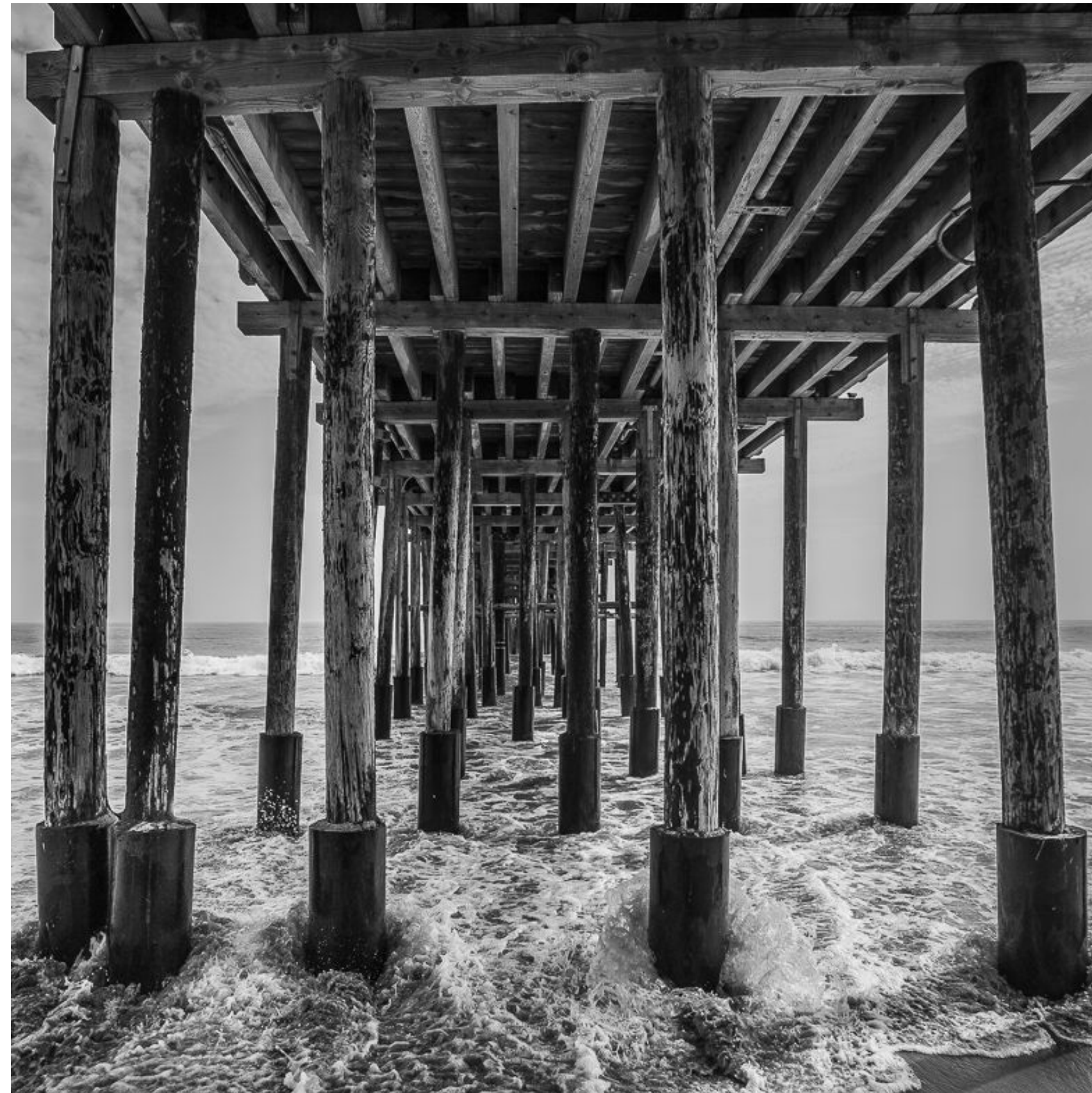
Imagen exterior. Estructura de muelle de 5 pilares de madera, distribuidos sobre vigas transversales, que sostienen vigas longitudinales cubiertas por un entablado de madera que conforma la superficie del muelle
