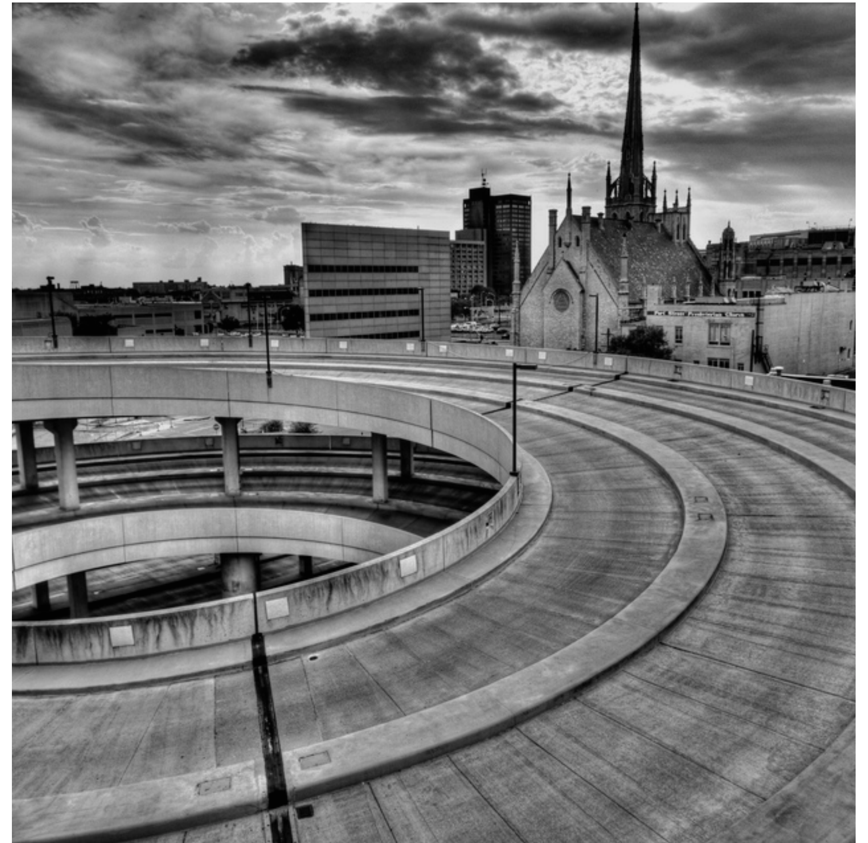
Imagen exterior. Rampa de tipología de circulación 06
