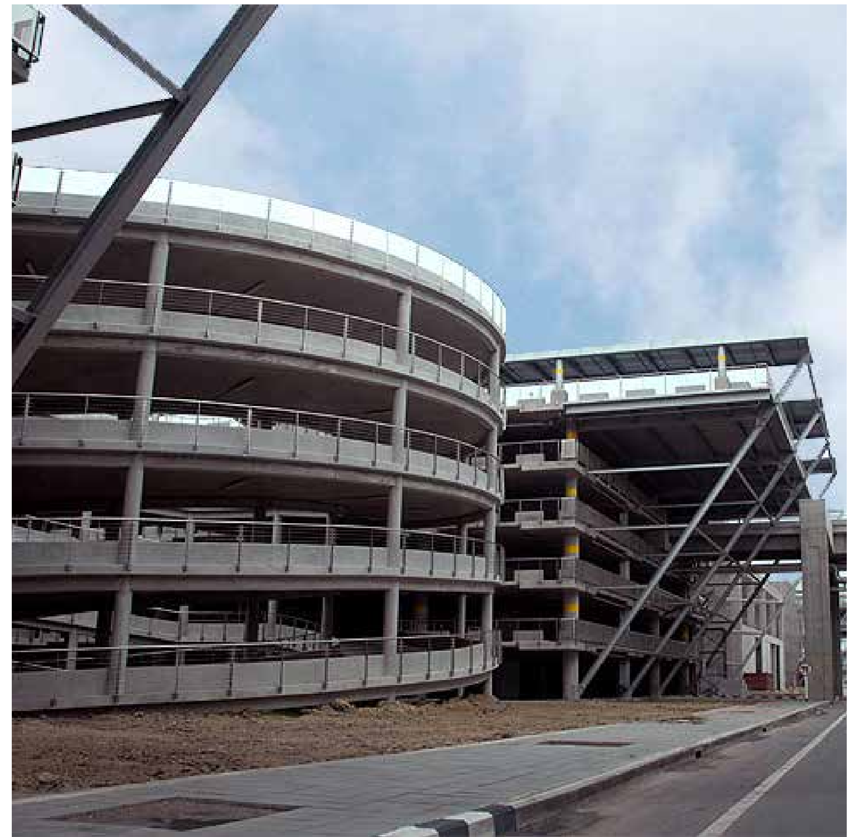
Imagen exterior. Bangkok. Rampa helicoidal doble del estacionamiento multinivel
