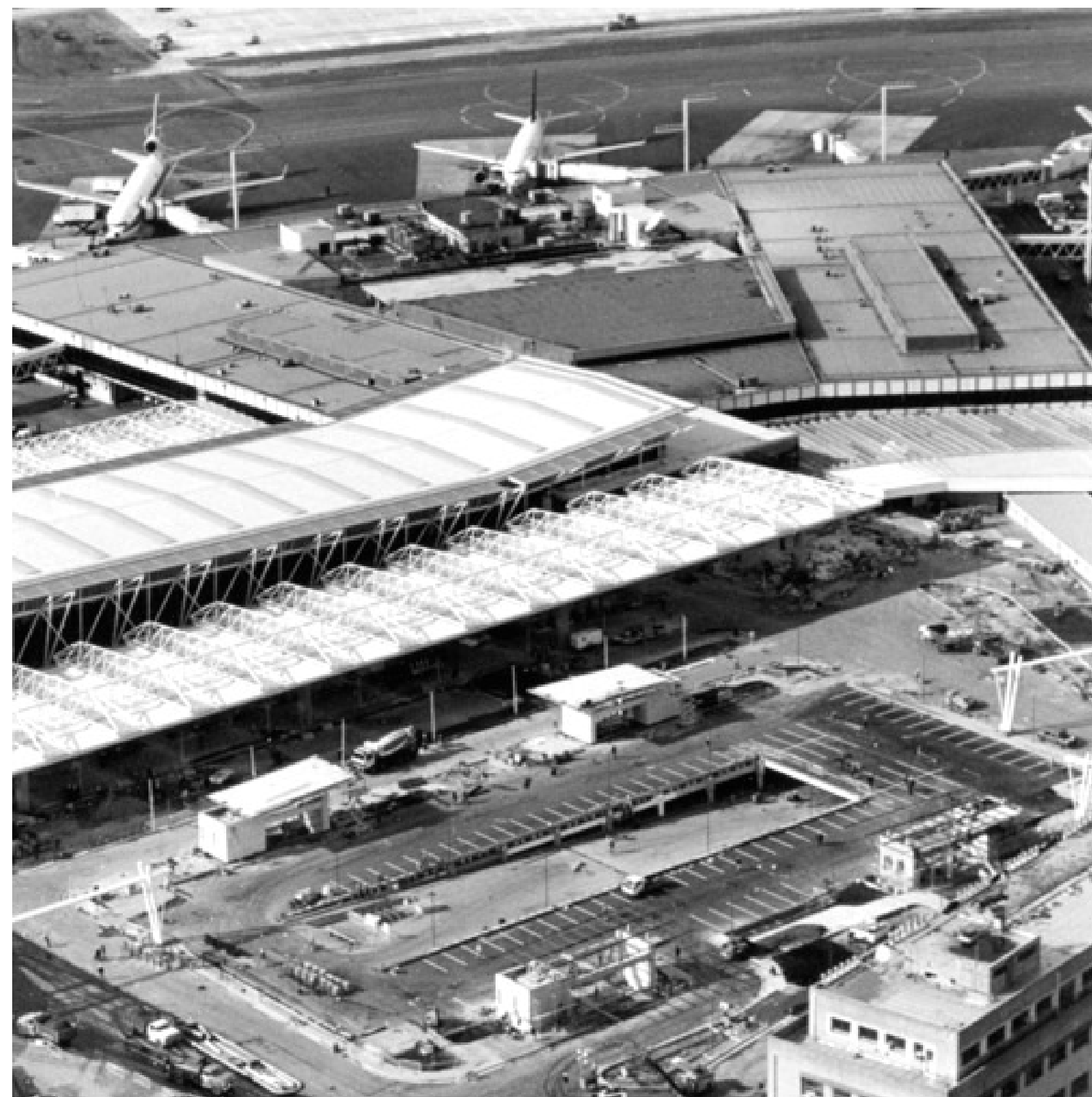
Imagen exterior. Ezeiza. Estacionamiento de la terminal A, durante su construcción
