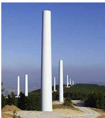
Torres tubulares: Consisten en grandes tubos de acero de forma tubular o cónica que ofrecen en su interior espacio para los equipos de suelo y para el acceso a resguardo hacia la góndola. Necesitan de una instalación más laboriosa y cara, pero ofrecen una mayor resistencia y menos mantenimiento necesario que las torres de celosía. Son las más empleadas en equipos de generación de energía.
