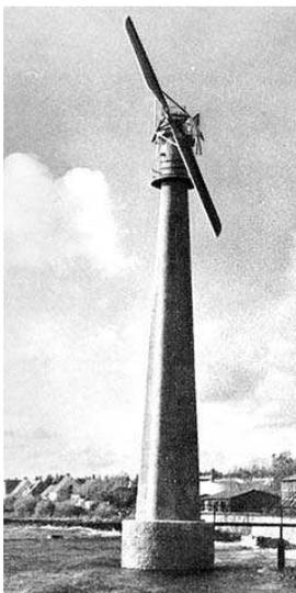
**Bipala:** Ahorra el peso y coste de una de las palas respecto a los aerogeneradores tripala, pero necesitan mayores velocidades de giro para producir la misma energía que aquellos. Para evitar el efecto desestabilizador necesitan de un diseño mucho más complejo, con un rotor basculante y amortiguadores que eviten el choque de las palas contra la torre
