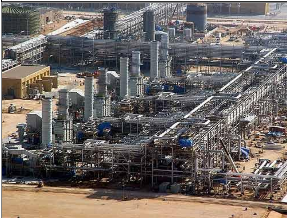
Fig 1 – Refinería – Oil & Gas
