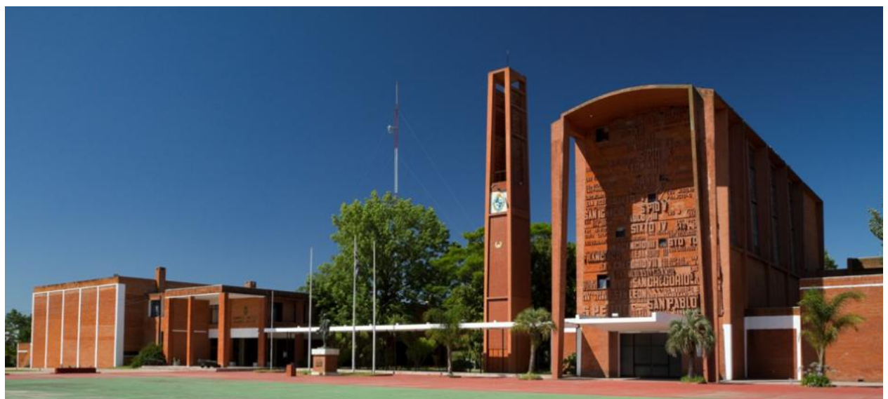
Fachada principal, estado actual.
