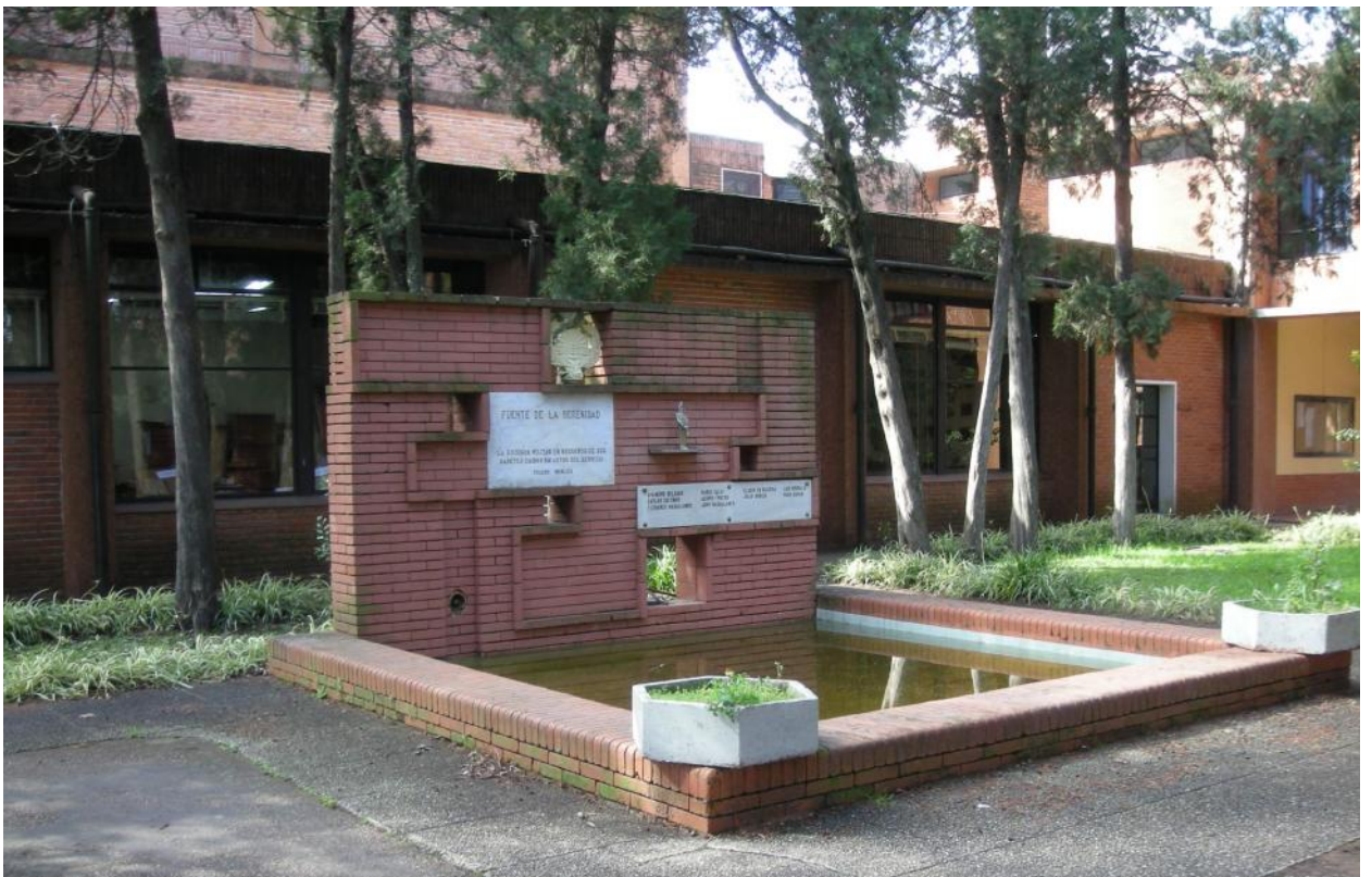
Fuente del patio de los profesores. Estado inicial (Archivo MPR.) y actual.
