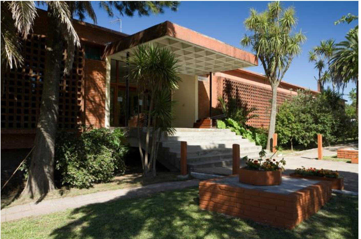
Hogar de las Hermanas en construcción. Archivo MPR. y estado actual.
