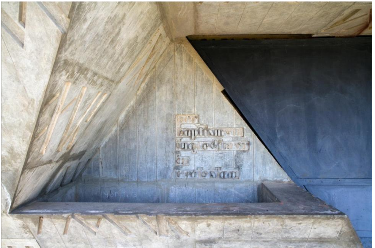
Bautisterio. Fachada norte, exterior.
