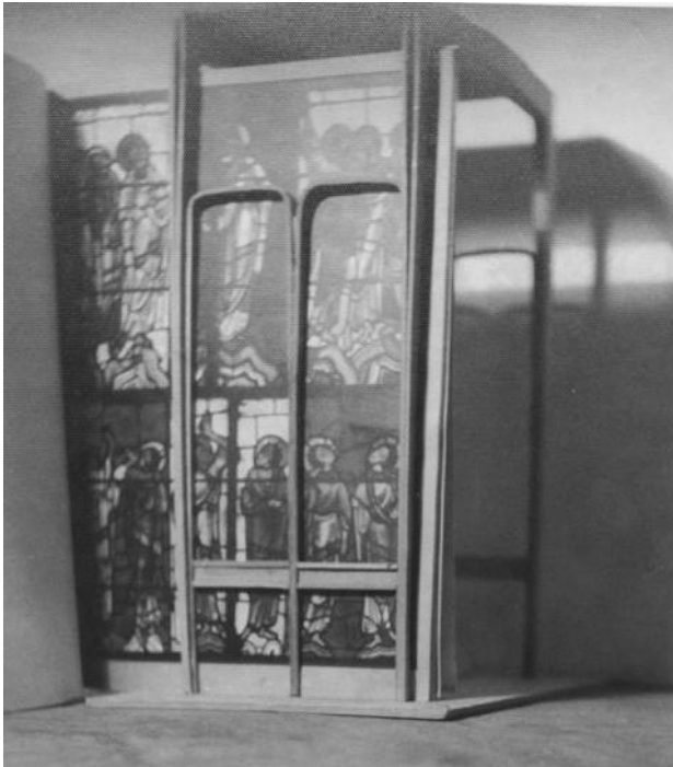
Maquetas de estudio de un tramo de la estructura de hormigón de la nave del templo; pilares y vigas pórtico con bóvedas delgadas. Entre la estructura se ubicarían los vitrales del Via Crucis. Archivo MPR.
