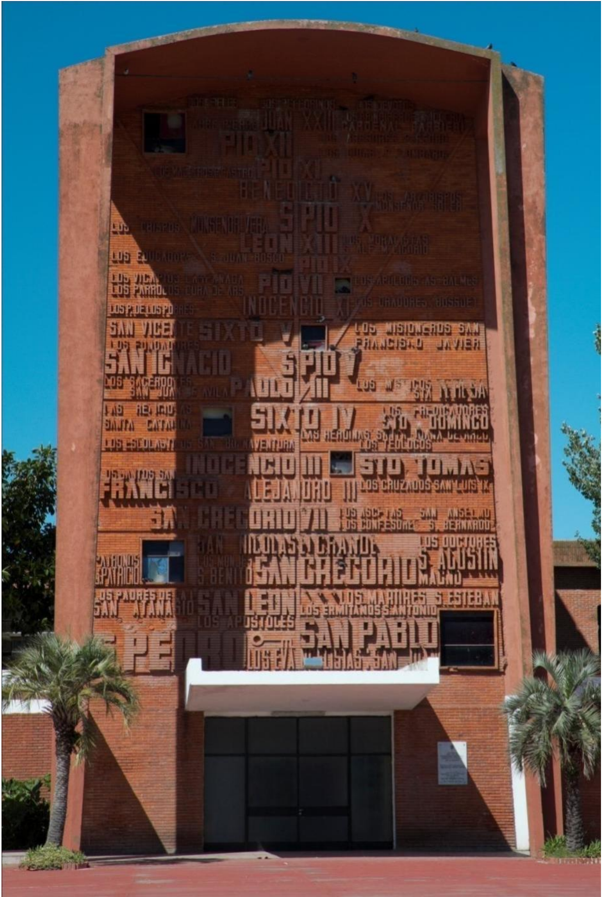
Fachada de la iglesia MPR. Estado actual.
