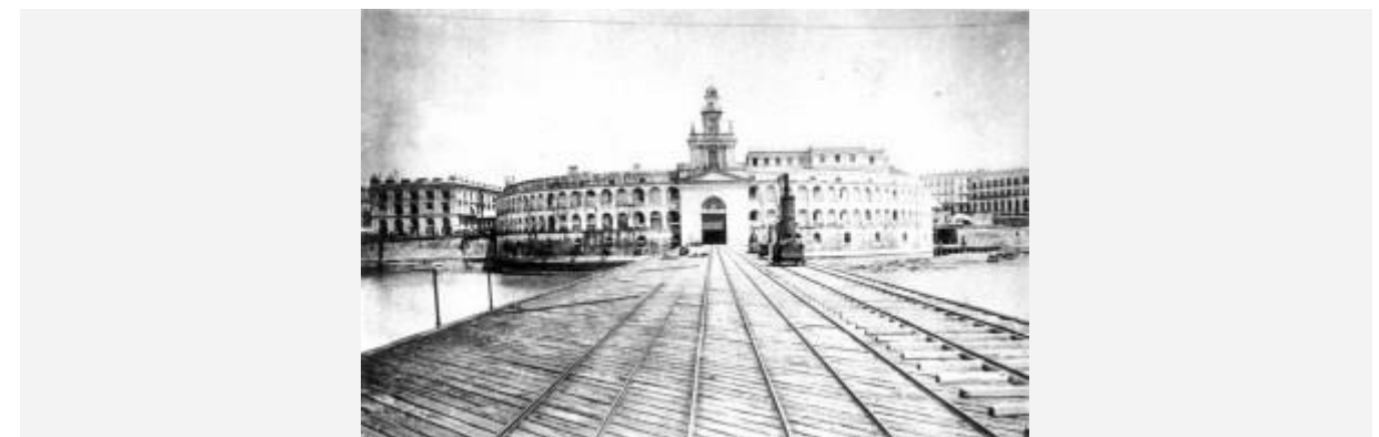
Vista del muelle hacia la Aduana, con el funcionamiento del sistema de vías y vagonetas.
