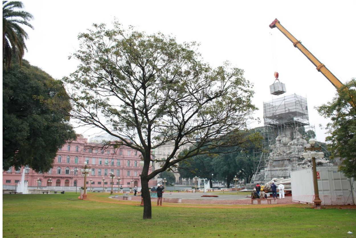
2013. Estatua de Cristoforo Colombo. Trabajos para sacar la estatua.
