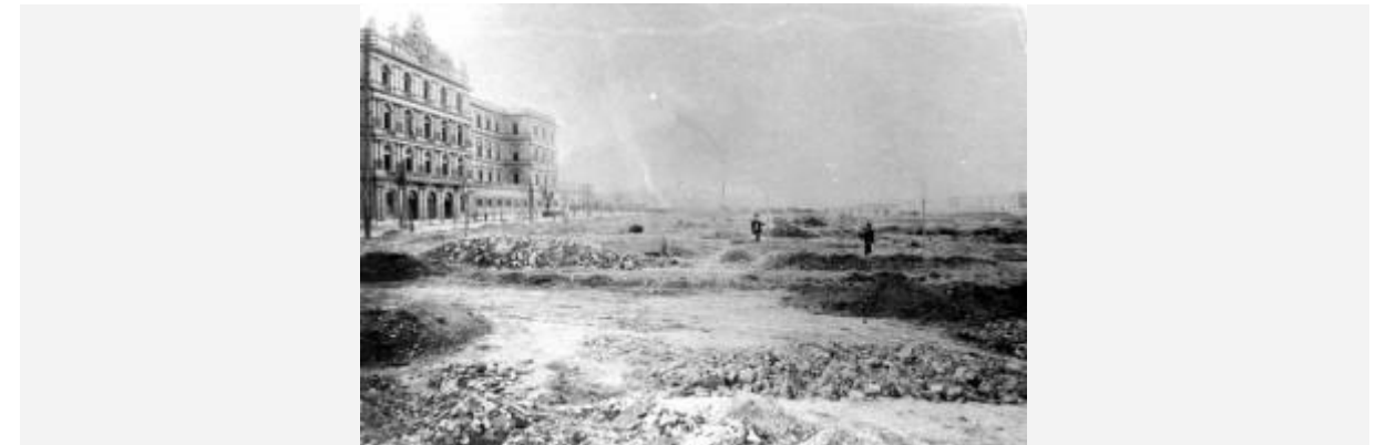
Fotografía tomada en el sector demolido de la Aduana de Taylor, hoy convertida en Parque Colón, frente a la Casa Rosada.
