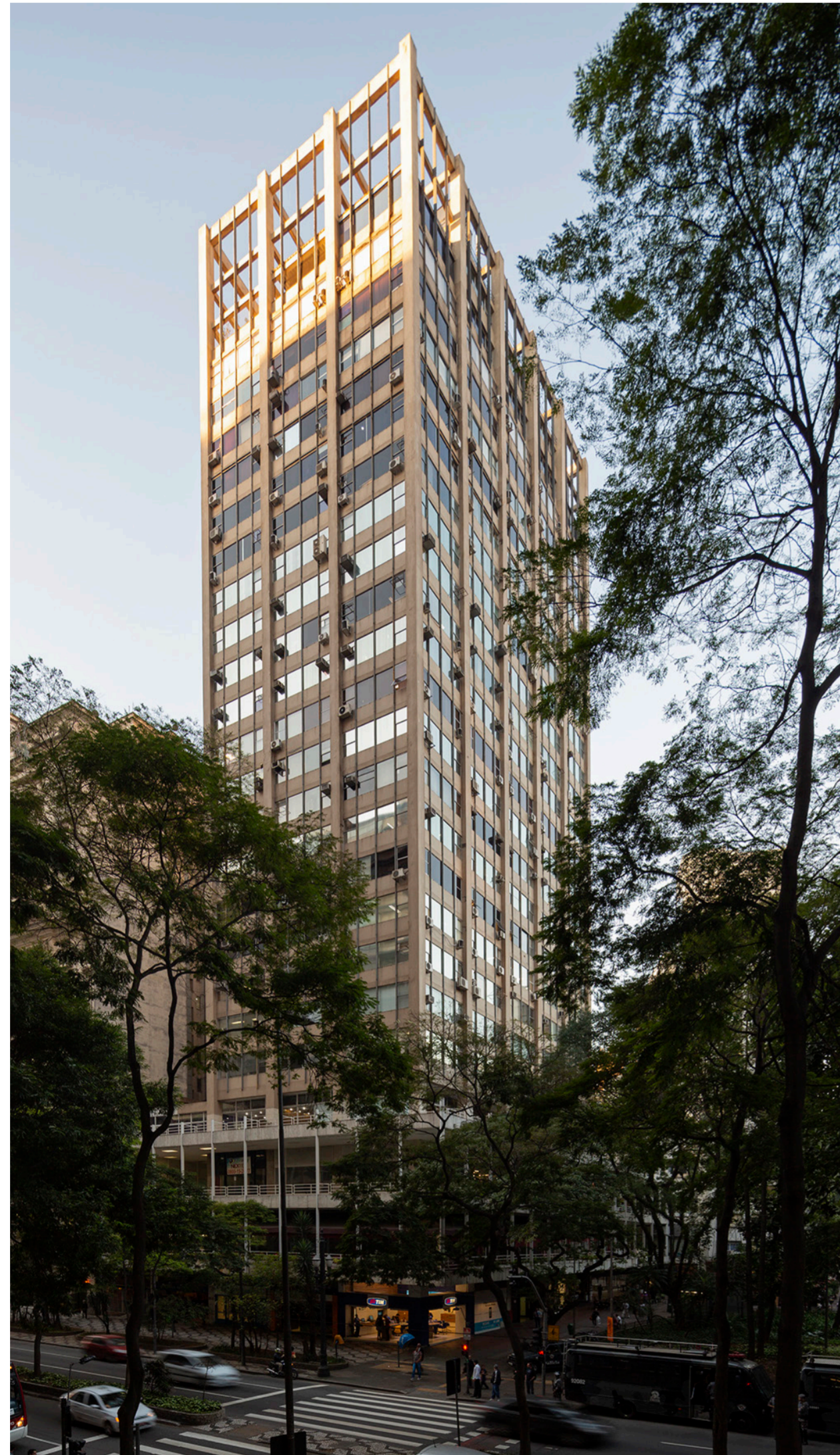
Galería Metrópole, San Pablo. Fotografía de la torre desde el Edificio Louvre. Leonardo Finotti, 2020. Fuente: www.leonardofinotti.com
