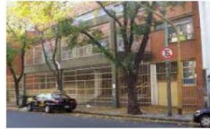
Los edificios provisorios son del tipo "Prenova", construcción pre moldeada. Su punto débil son los encuentros y filtraciones, no solucionables a la fecha. Los edificios tipo Cacciatore tienen un sistema constructivo con estructura independiente, doble muros externos. Otro punto débil es la chapa doblada sin protección en los marcos y hojas de importantes dimensiones que lo tornan pesado.
