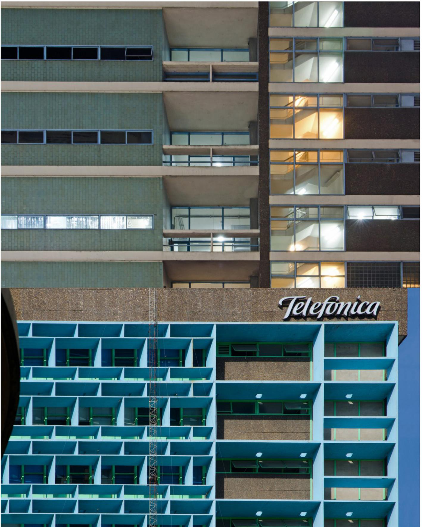
Imágenes: Fotografías exteriores actuales del edificio, podemos observar su modulación, sus variantes soluciones técnicas entre las fachadas y la inclusión de elementos de control climáticos: los parasoles. (2012). Fuente: Extraídas del archivo del arquitecto Alejandro Goldemberg.
