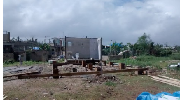
Casa Nancy: El módulo se niveló a la altura del baño existente. Nancy decidió contratar mano de obra para hacer las bases de la vivienda en hormigón armado. Foto: TECHO (2018)
