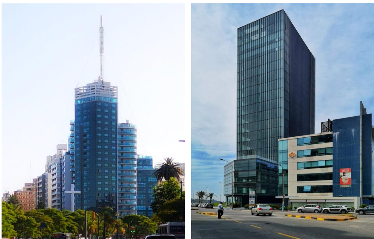
Fig.118 – Articulación por adición: Escalonamiento en Torre del Congreso y pequeños pies en T. Plaza Alemania.
