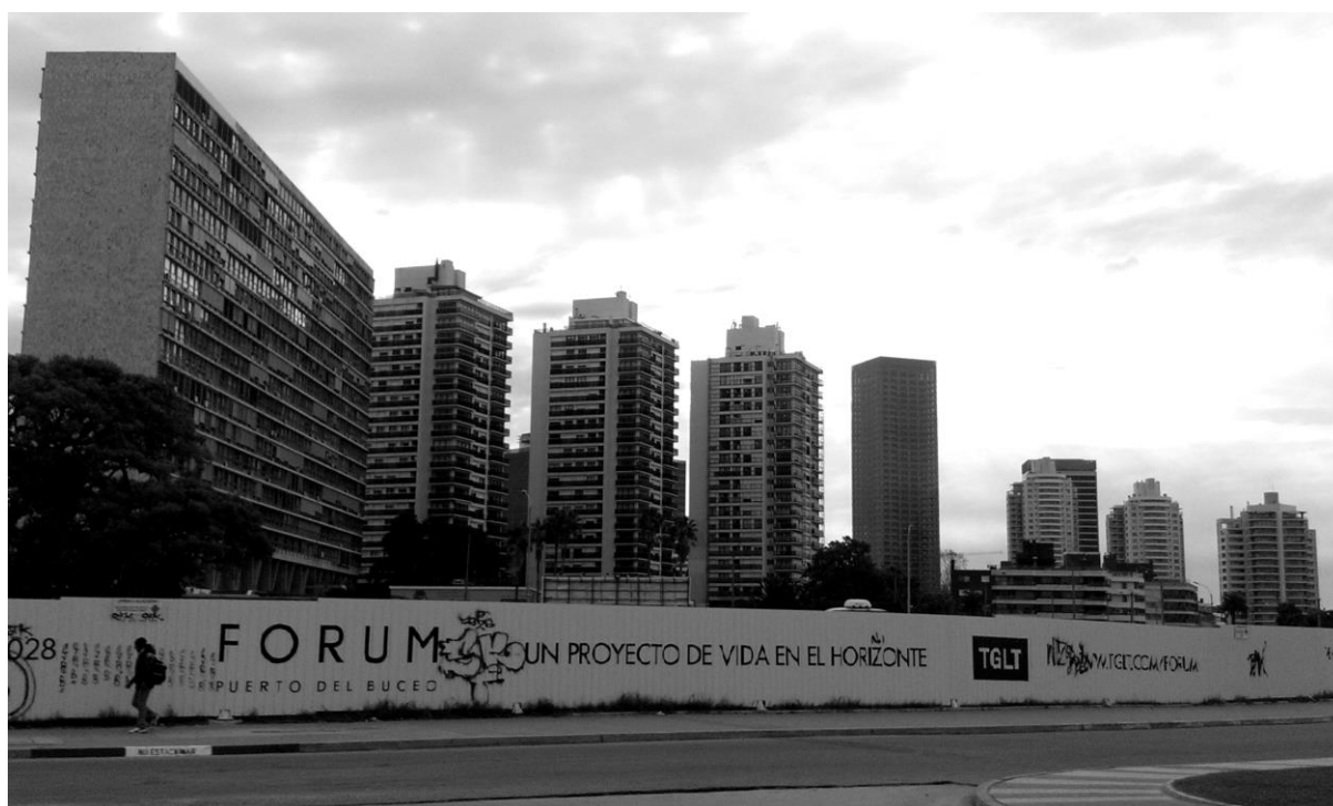
Fig.68 - El predio donde se construiría FORUM. De derecha a izquierda, se observa el Panamericano, las Torres del Puerto, la Torre de WTC4 y las Torres Náuticas.
