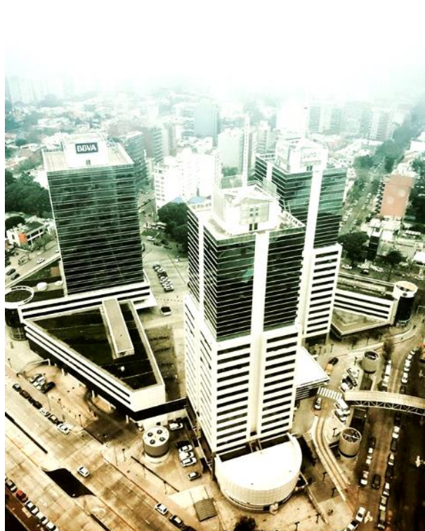
Fig.71 – WTC1, 2 y 3, vistas desde WTC4.
