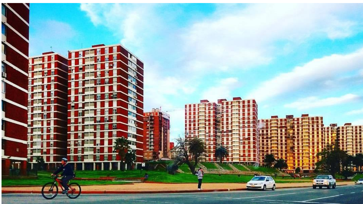
Fig.61 – Torres del Plan de Renovación Urbana Barrio Sur.
