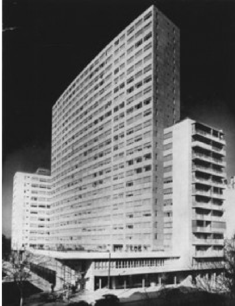
Fig. 23. Casa colectiva de la CEHO en Av. Rivadavia, Buenos Aires. Arq. Fermín Bereterbide, 1941-1955. Fuente: Juan Molina y Vedia y Rolando Shere, Fermín Bereterbide, la construcción de lo imposible , Buenos Aires: Colihue, 1997.
