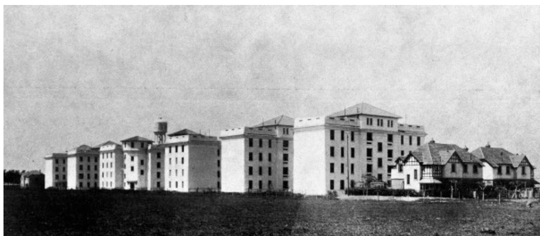
Fig. 6. Vista de los pabellones colectivos y las casas individuales. Ampliación Barrio Rawson, Buenos Aires. Comisión Nacional de Casas Baratas, 1933. Fuente: La Habitación Popular , no. 2, 9/1934.
