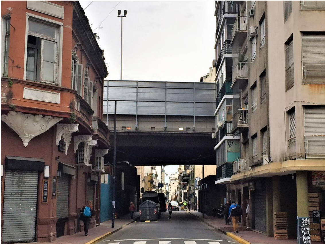
Ilustración 23 Bajo Autopista de la calle Bolívar
