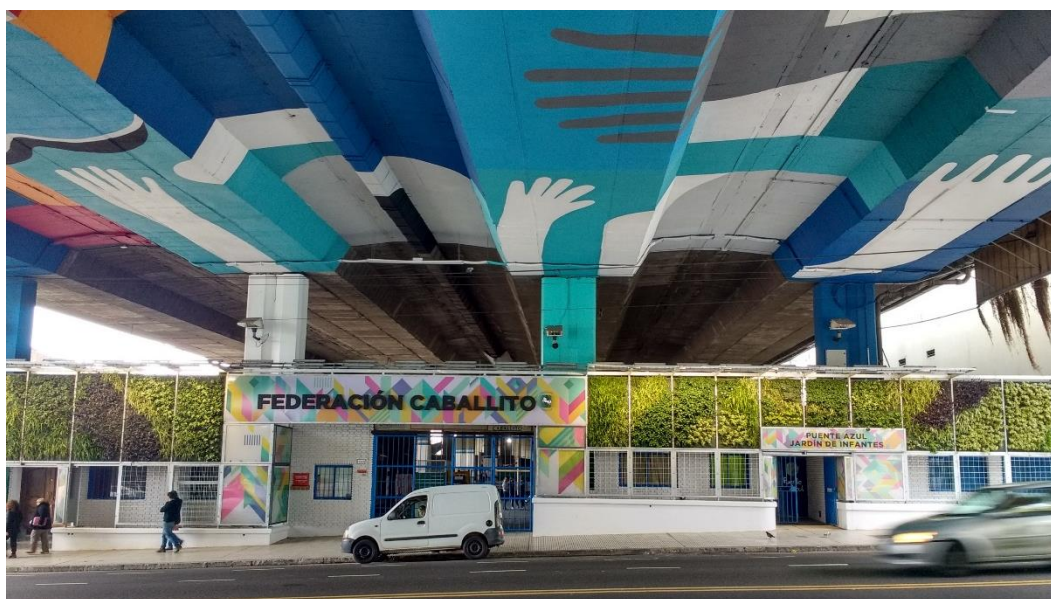
Ilustración 25 Bajo Autopista Av. La Plata - Obra finalizada 2017
