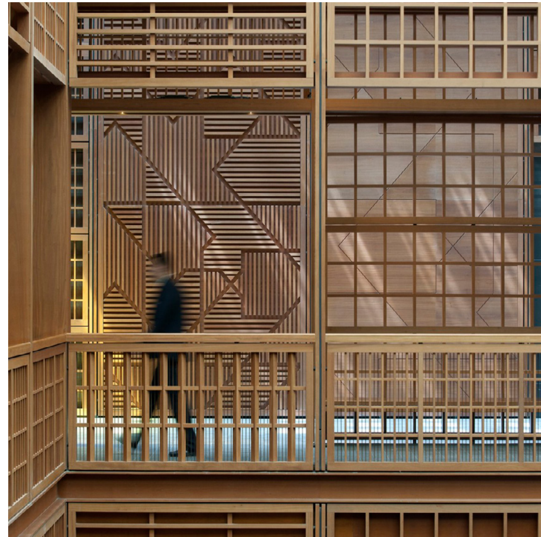
Fotografía interior. Introducción al Modelo de Desarrollo. Edificio de plataformas altas. Abu Dhabi Central Market, Norman Foster. Abu Dhabi, 2014. Los cerramientos ciegos del mercado se encuentran materializados mediante la utilización de paneles de madera con múltiples patrones relacionados con la cultura local.
