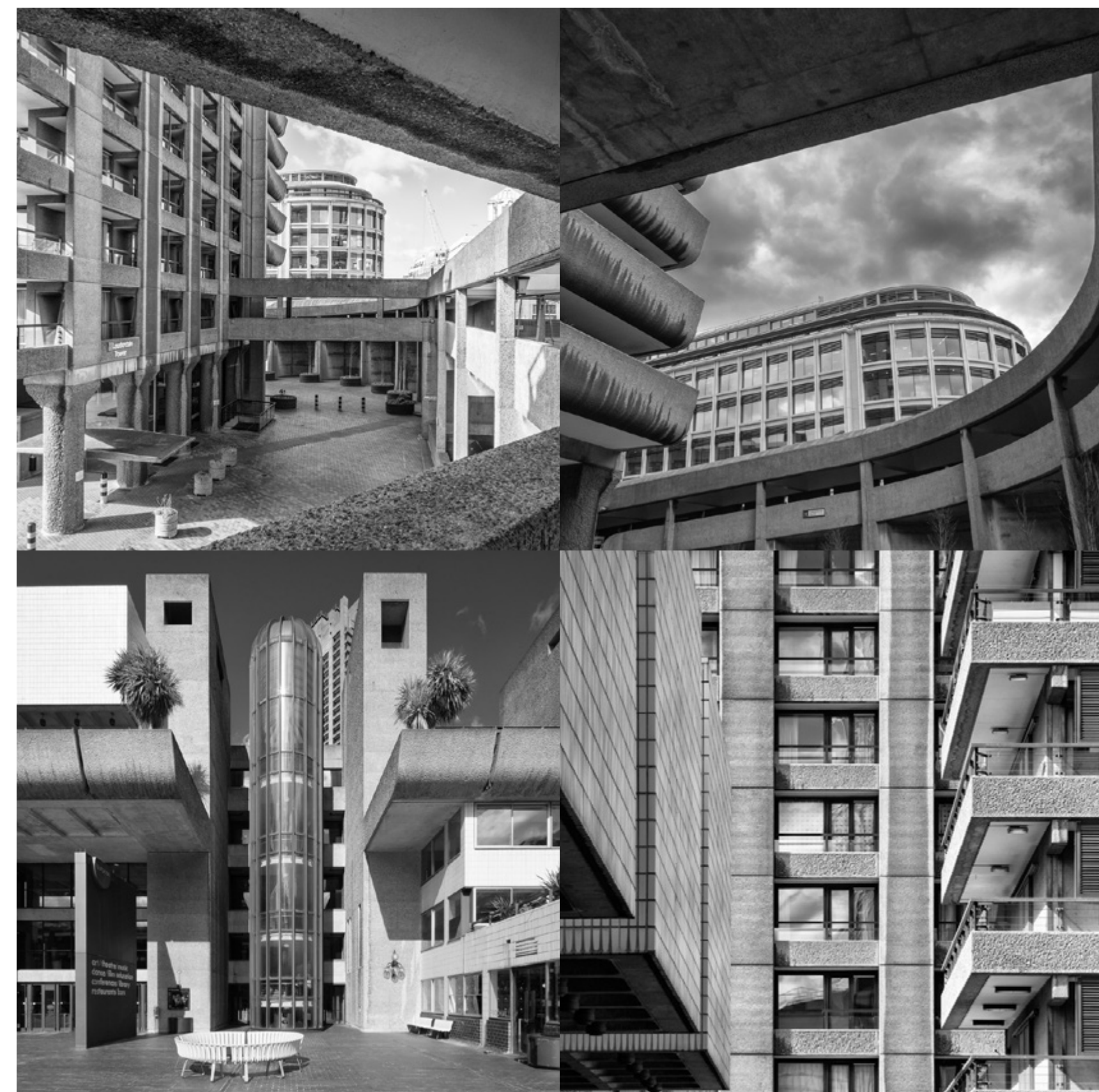
Fotografía exterior. Introducción al modelo utópico. Edificio de masas expansivas. Barbican Center, Chamberlin, Powell y Bon Architects. Londres, Inglaterra, 1976. Patio central, la estructura se vuelve parte fundamental y predominante en el proyecto arquitectónico. Se detectan columnas de sección rectangular, cuadrada y adosadas a los muros; parapetos rectos, curvos y fachadas vidriadas. Esta variedad estructural y resolutive hace que el edificio pueda ser leído como una yuxtaposición de partes, pero que a su vez se ven unificadas y cohesionadas por la resolución técnica a partir del hormigón armado que genera una imagen de conjunto.
