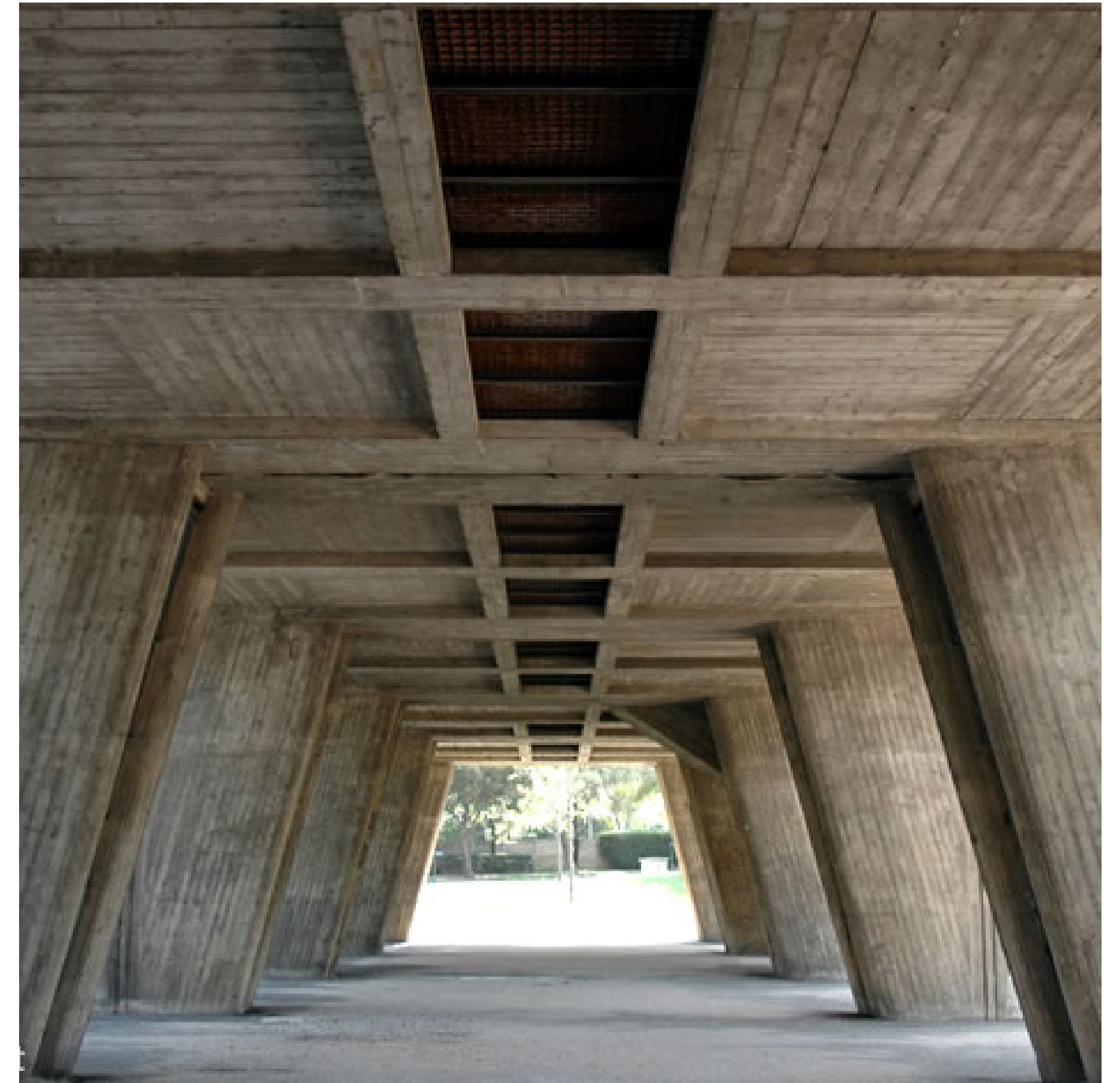
Fotografía exterior. Introducción al modelo utópico. Planta baja de la Unité de Habitation, Le Corbusier. Marsella, Francia, 1952. Se aprecia la masividad de la estructura en relación al espacio, la misma se vuelve no solo soporte estructural sino parte fundamental de la composición de las edificaciones brutalistas. Sumado a esto, el hormigón armado es utilizado de manera que quedan expuestos los vestigios de su construcción sin ningún tipo de modificación, resaltando la impronta brutal.
