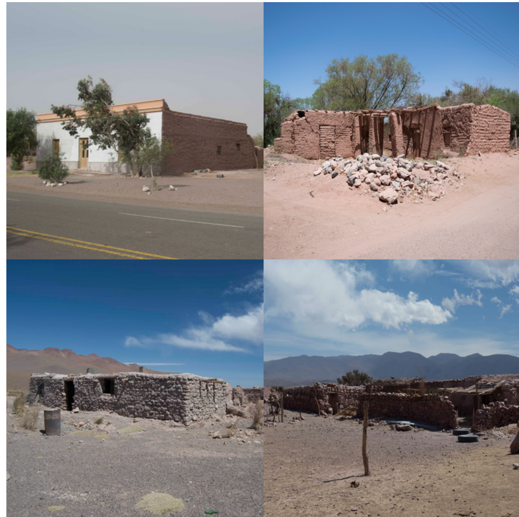
Fotografías. Edificaciones de la región de cuyo, límite con Puna. Las construcciones a medida que se alejan de los centros urbanos aumentan su grado de ruinosidad, al igual que sucede con el aumento en altura. Las mismas se encuentran construidas en su totalidad mediante la técnica del adobe. De derecha a izquierda de arriba hacia abajo según cercanía a los centros urbanos y altura sobre el nivel del mar. 01_500m. Altura SNM. 1500m. 02_50km. Altura SNM. 2000m. 03_150km. Altura SNM. 2800m. 04_220km. Altura SNM. 2900m. Fotografía Victoria Pavesi, 2017.
