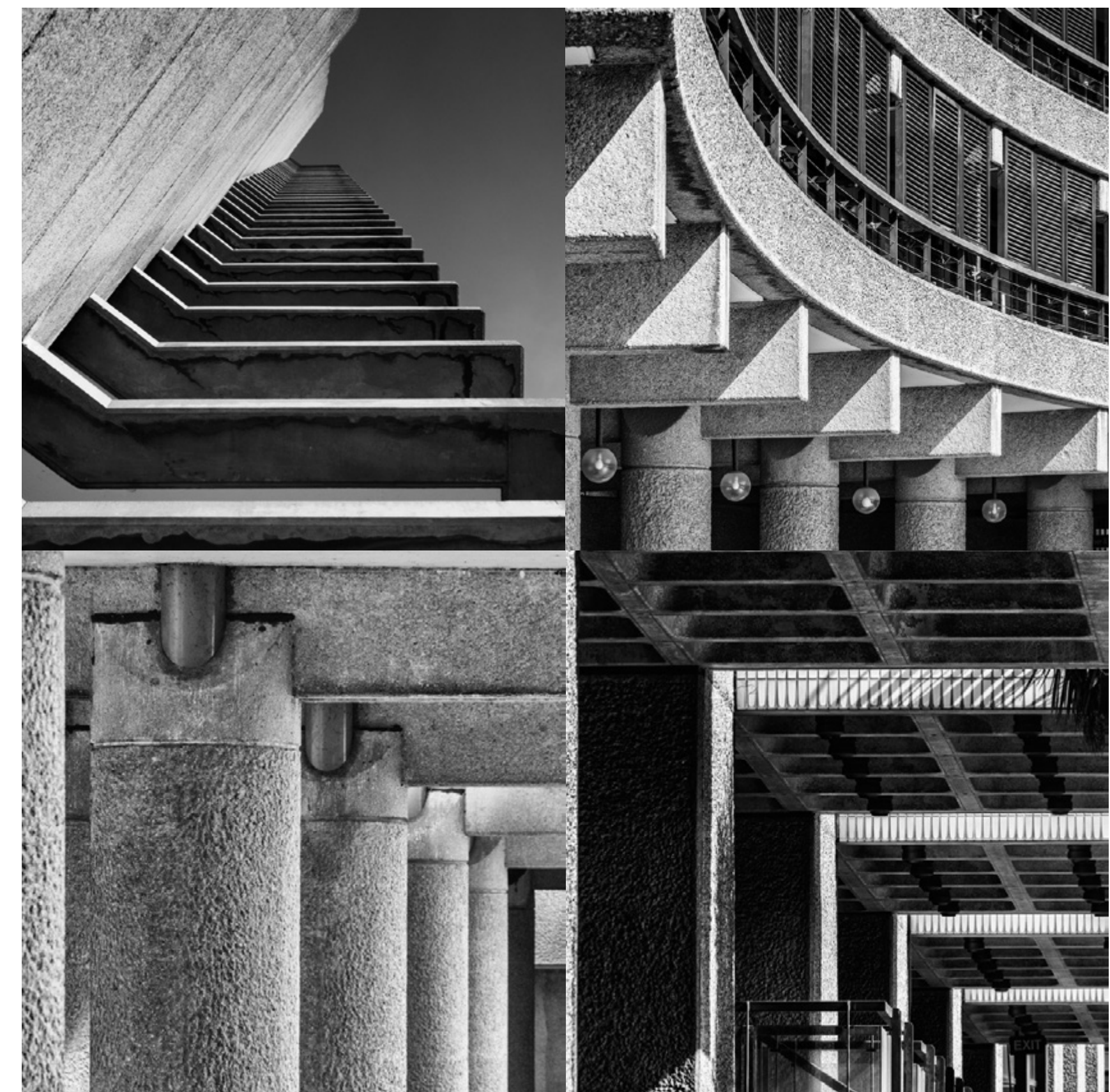
Fotografía exterior. Introducción al modelo de utópico. Edificio de masas expansivas. Barbican Center, Chamberlin, Powell y Bon Architects. Londres, Inglaterra, 1976. Detalles resolutivos. La estructura se vuelve parte fundamental y predominante en el proyecto arquitectónico. La resolución estructural se expone en todas las situaciones del edificio construyendo una impronta que permite entender el funcionamiento tectónico de la masas y el recorrido de las cargas estructurales.
