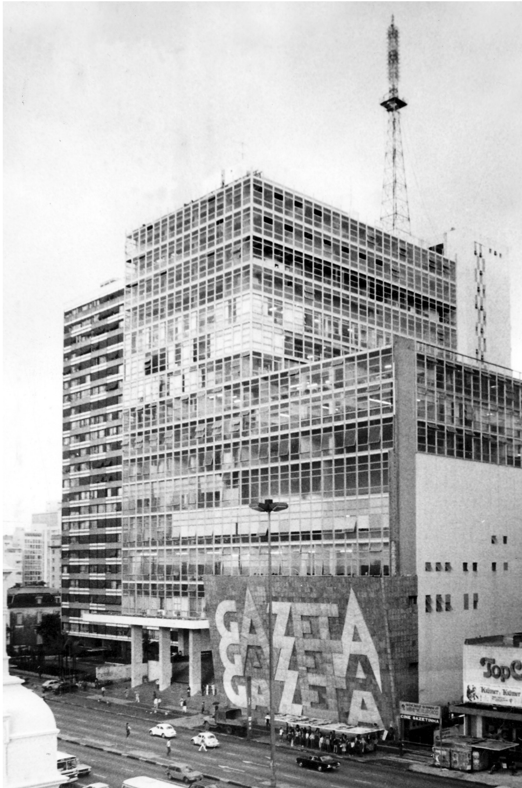
Fotografía frontal del Edificio Gazeta
