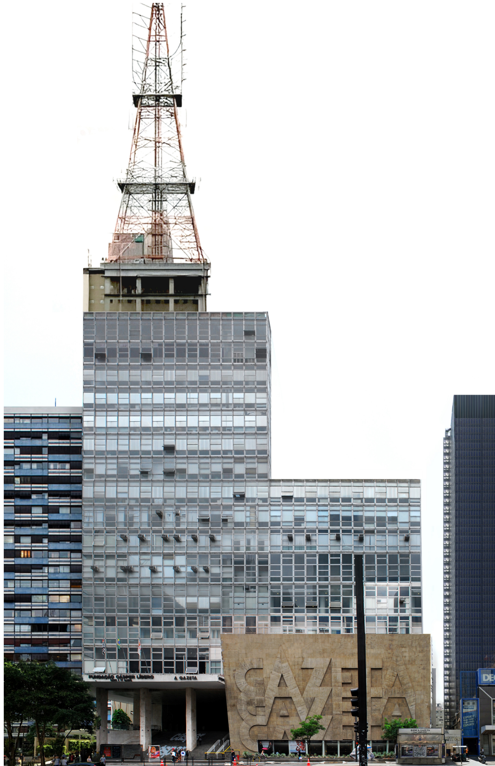
Fotografía del Edificio Gazeta
