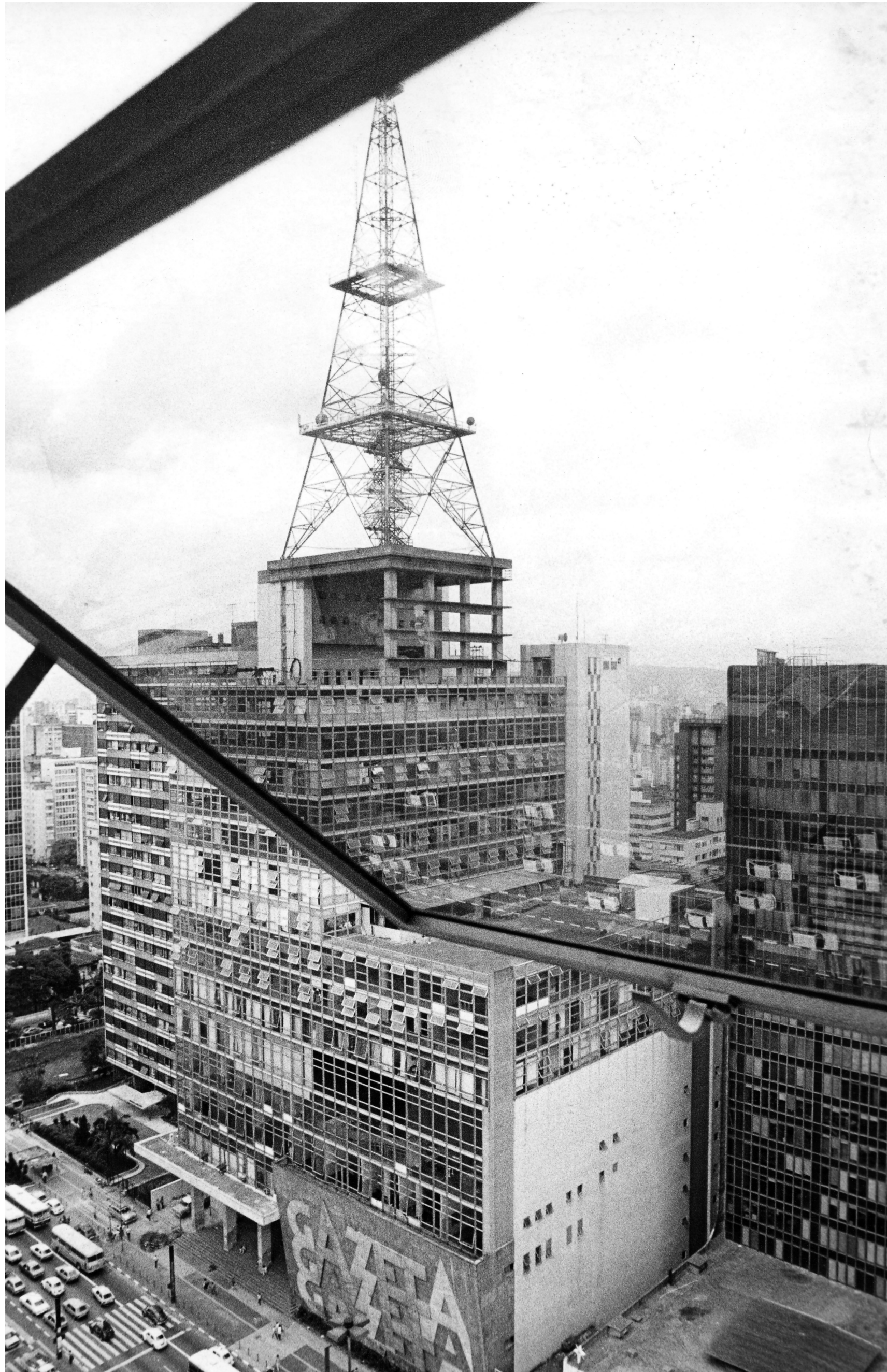
Fotografía frontal del Edificio Gazeta
