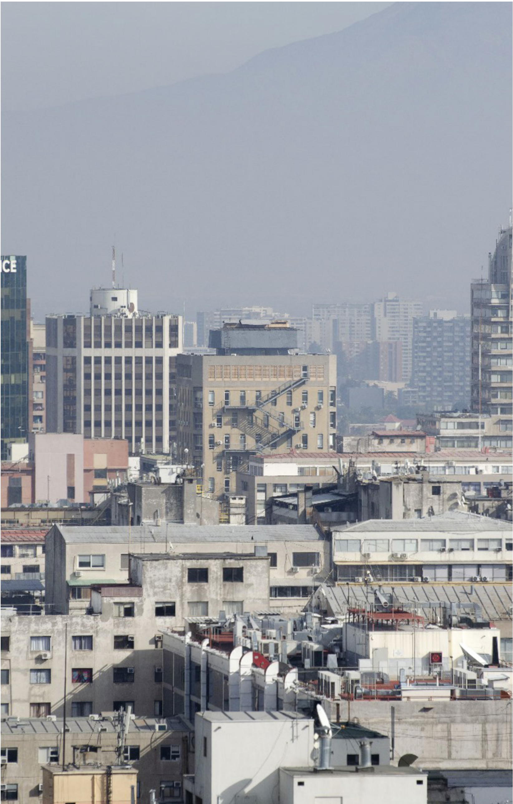
Fotografía actual - Ministerio de Trabajo y Previsión Social desde el edificio Plaza de Armas. Autoría propia.
