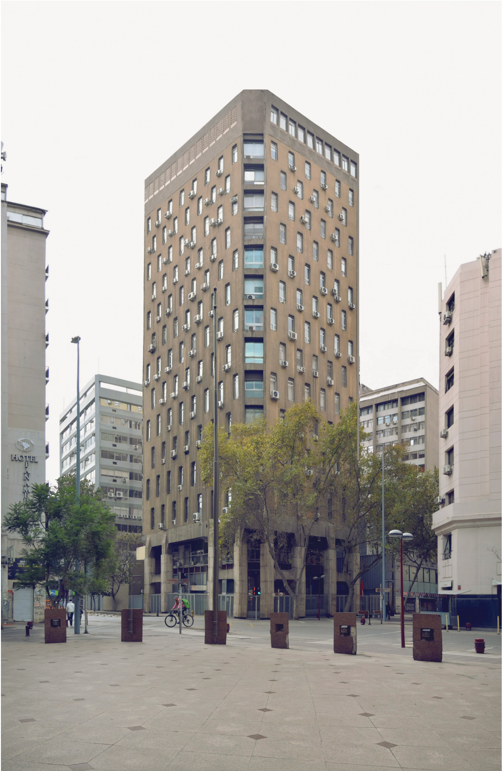
Fotografía actual. Esquina calles Teatinos y Huérfanos. Autoría Propia.
