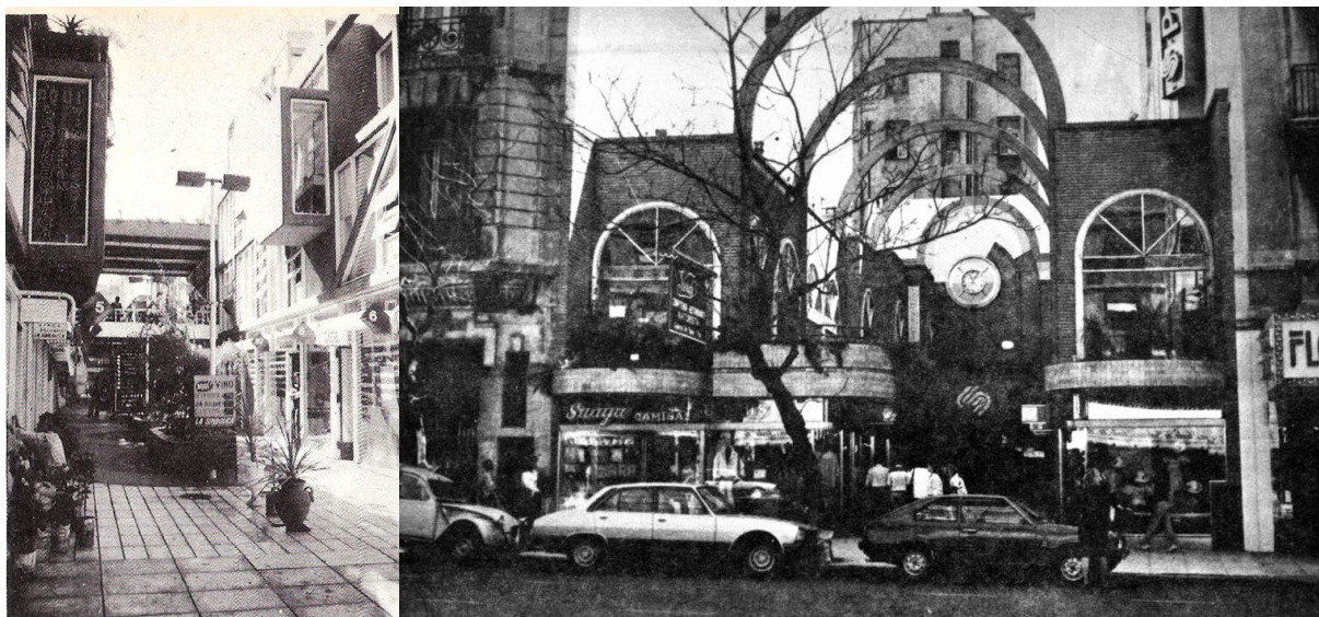
Fig. 1.50: Vía Valeria, circulación a cielo abierto. Juan Carlos López y Asociados, Vía Valeria, 1976. Fotografía: desconocido. Fuente: A/mbiente , núm. 43 (1984), s/n.
