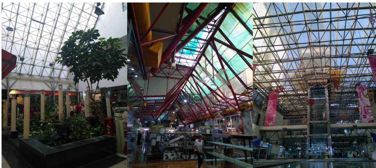
Figs. 1.41, 1.42 y 1.43: cubiertas sobre galerías del Estudio Sujoy (de izquierda a derecha: Galería de la Flor, Galería del Caminante y Galería del Siglo).
