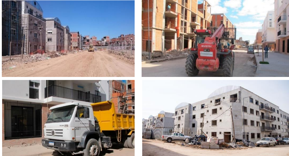
Figura 46. Imágenes de la etapa de construcción del conjunto. Fuente: buenosaires.gob.ar
