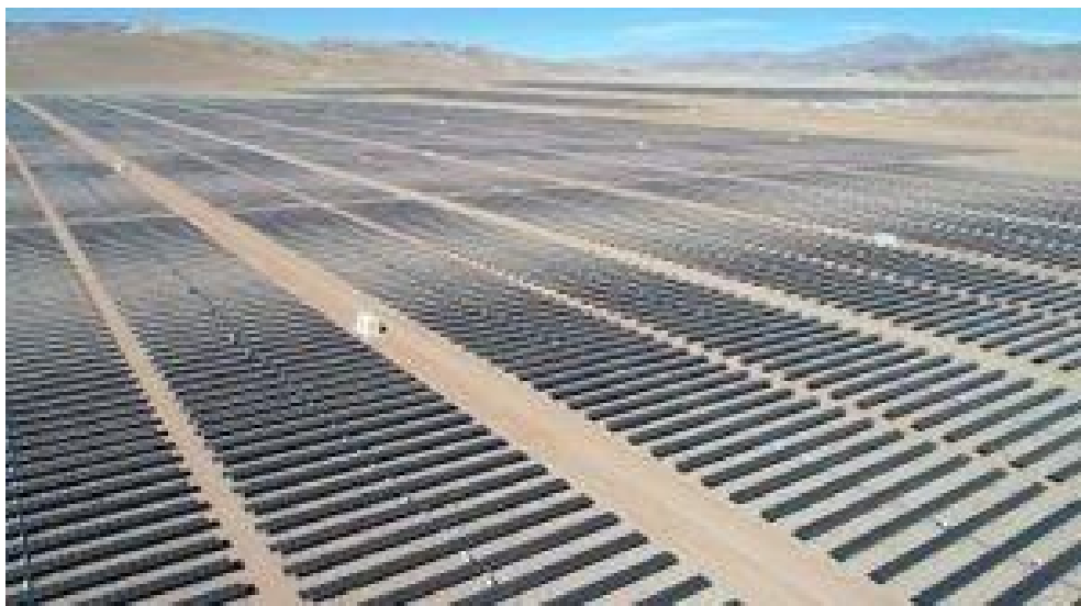
Figura 73. Parque solar Cauchari Jujuy, 300MW de potencia instalada, altura: 4.000 metros sobre el nivel del mar. Fuente: Jemse.gob.ar .
