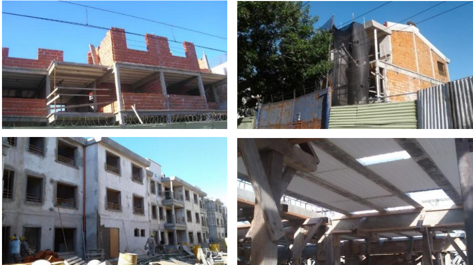
Figura 52. Imágenes de la etapa de construcción del conjunto. Fuente: buenosaires.gob.ar .
