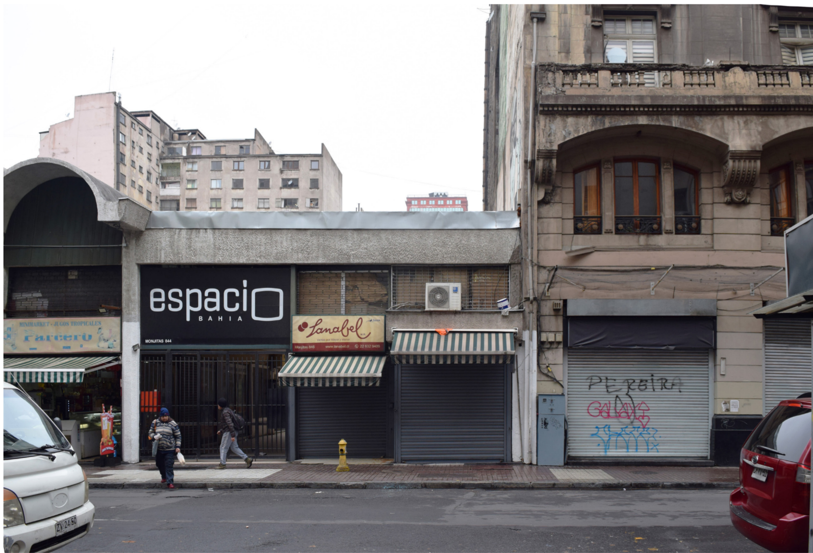
Imagen: Fotografía Edificio Bahía. Entrada a la galería sobre calle Monjitas. Autoría propia.
