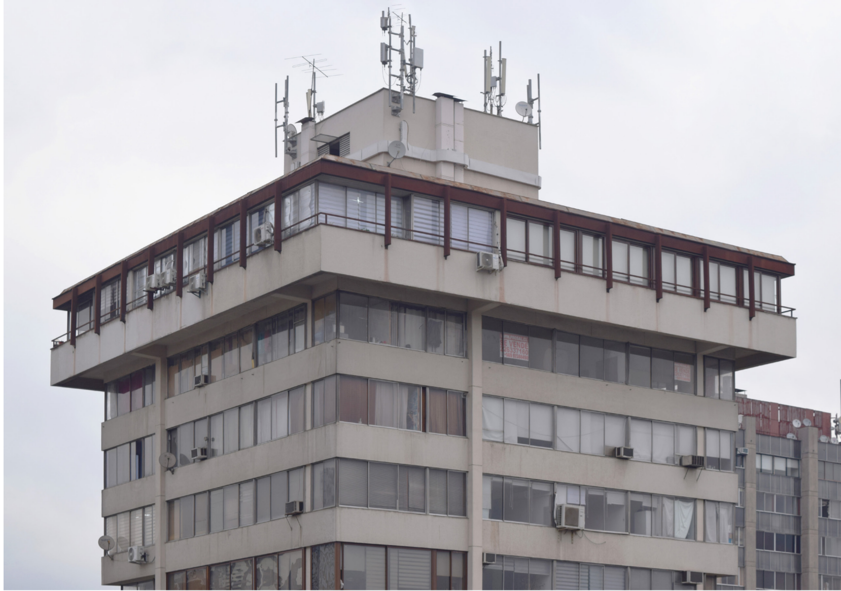
Imagen: Fotografía Edificio Bahía. Remate del edificio. Autoría propia.
