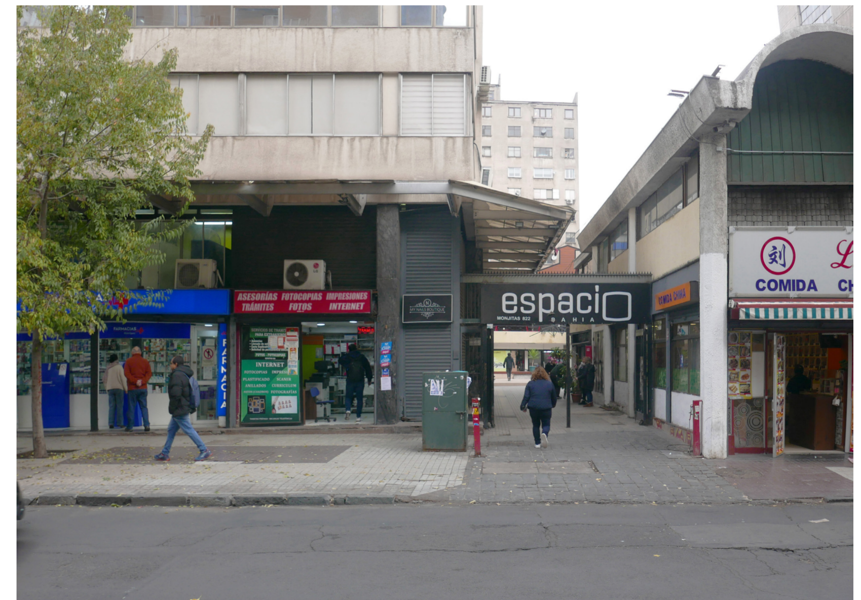
Imagen: Fotografía Edificio Bahía. Entrada a la galería sobre calle Monjitas. Autoría propia.
