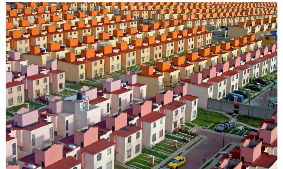
Imágen del complejo de viviendas San Buenaventura en Ixtapaluca (al este de la Ciudad de México)
