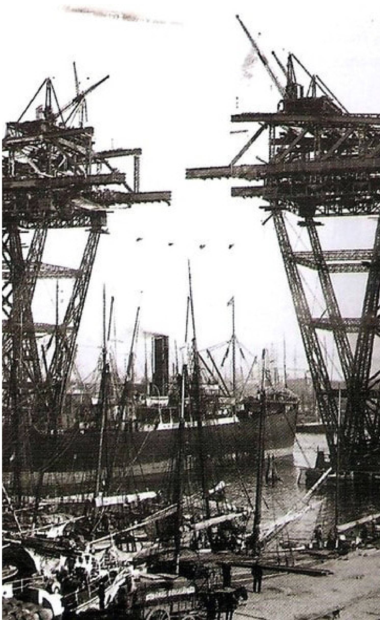
Puente Transbordador Nicolás Avellaneda, Riachuelo, límite entre La Boca e Isla Maciel. Documenta el proceso de construcción del puente transbordador, mostrando las dos torres metálicas principales en ejecución. Se evidencia la magnitud de la infraestructura portuaria y el carácter industrial del área, así como el rol estratégico del río como vía de transporte y producción a comienzos del siglo XX. Autor desconocido, 1908–1914. Fuente: Autor desconocido, Construcción del Puente Transbordador Nicolás Avellaneda.
