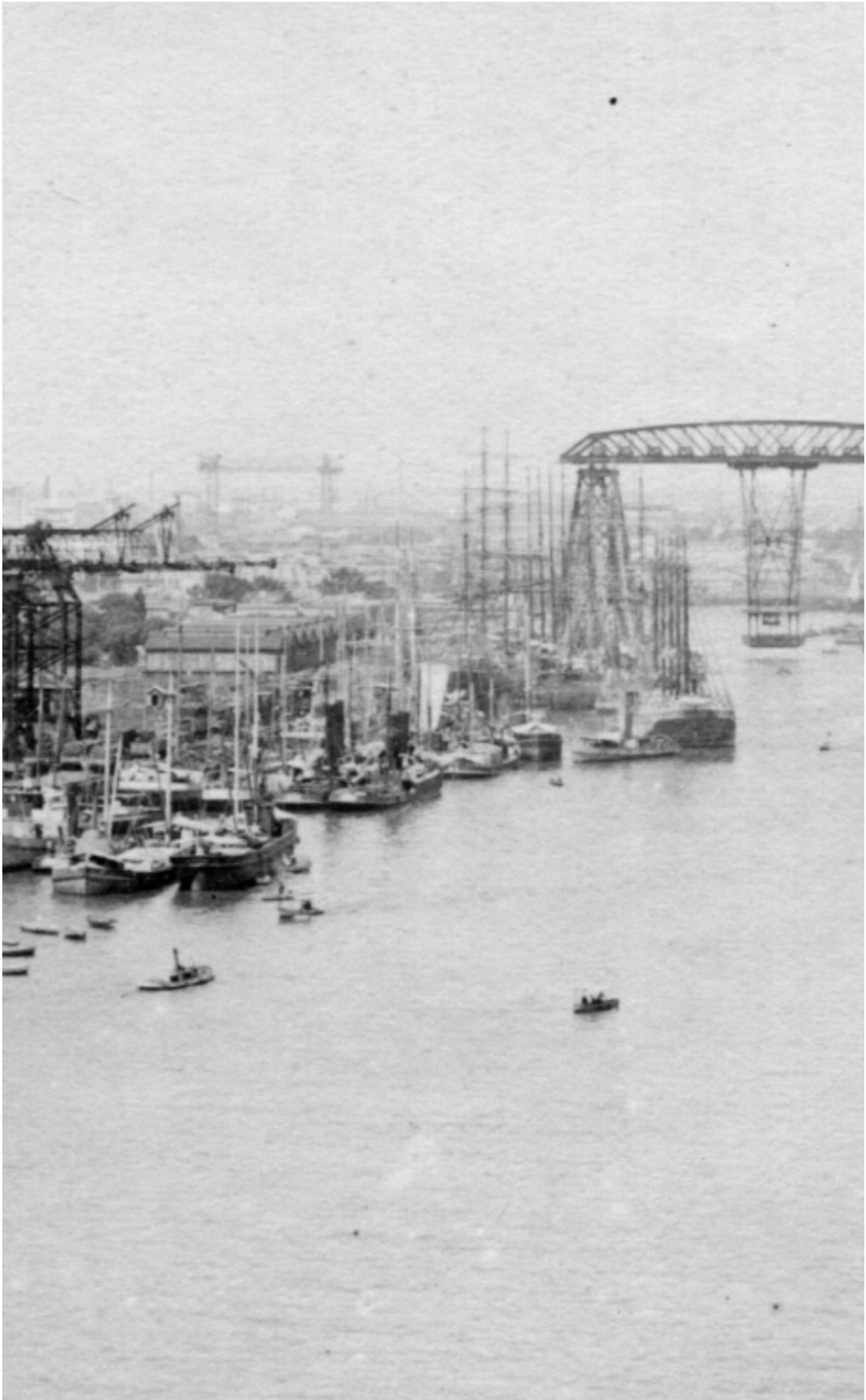
Riachuelo, sector Isla Maciel–La Boca, Área Metropolitana de Buenos Aires. Vista panorámica del frente portuario sobre el Riachuelo, con numerosas embarcaciones amarradas, mástiles y estructuras navales en primer plano. Al fondo se distingue el Puente Transbordador Nicolás Avellaneda en proceso de construcción. Autor desconocido, 1908–1914. Fuente: Autor desconocido, Vista del Riachuelo y construcción del Puente Transbordador Nicolás Avellaneda.
