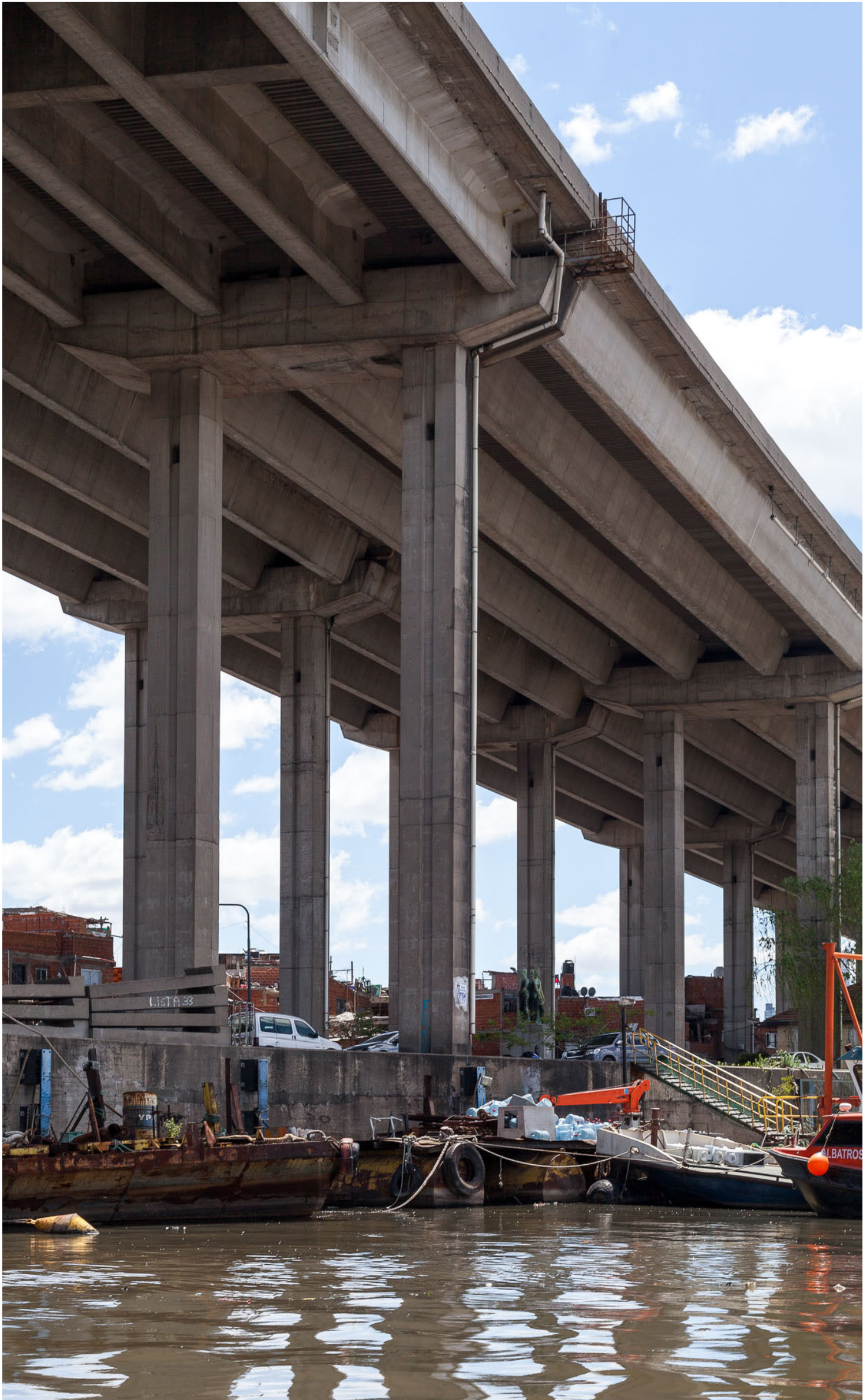
Autopista Buenos Aires–La Plata, Ciudad de Buenos Aires / Provincia de Buenos Aires. Estructura del puente vial elevado que cruza el Riachuelo, sostenido por pilares de hormigón armado. Autor: Javier Agustín Rojas. Fuente: Rojas, Javier Agustín, Puente sobre el Riachuelo de la Autopista Buenos Aires–La Plata (Buenos Aires: obra propia).
