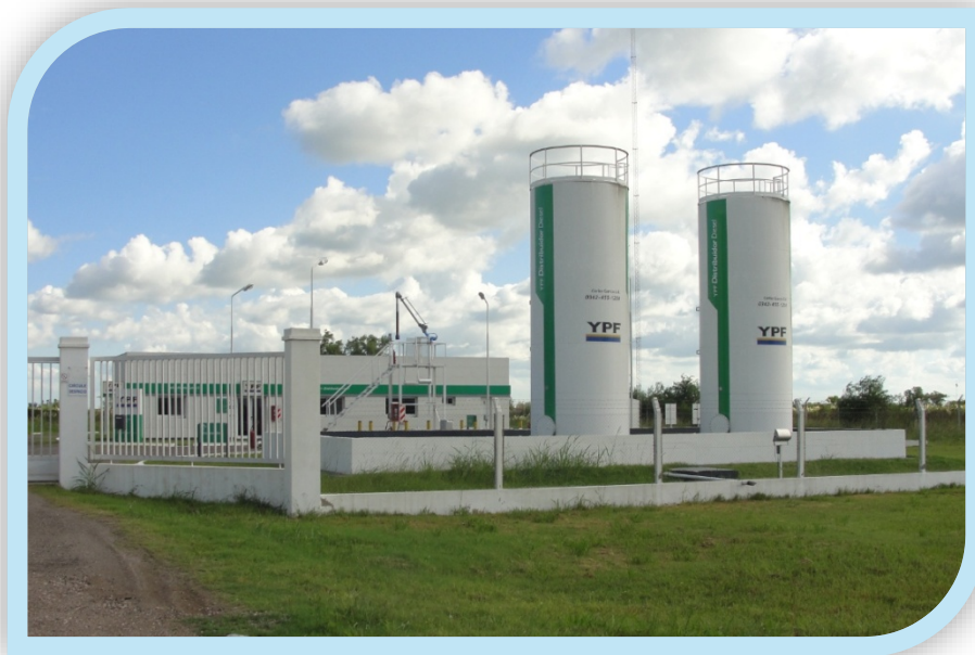
Figura 10 Frente de la Planta CAGSA – Santo Tomé
