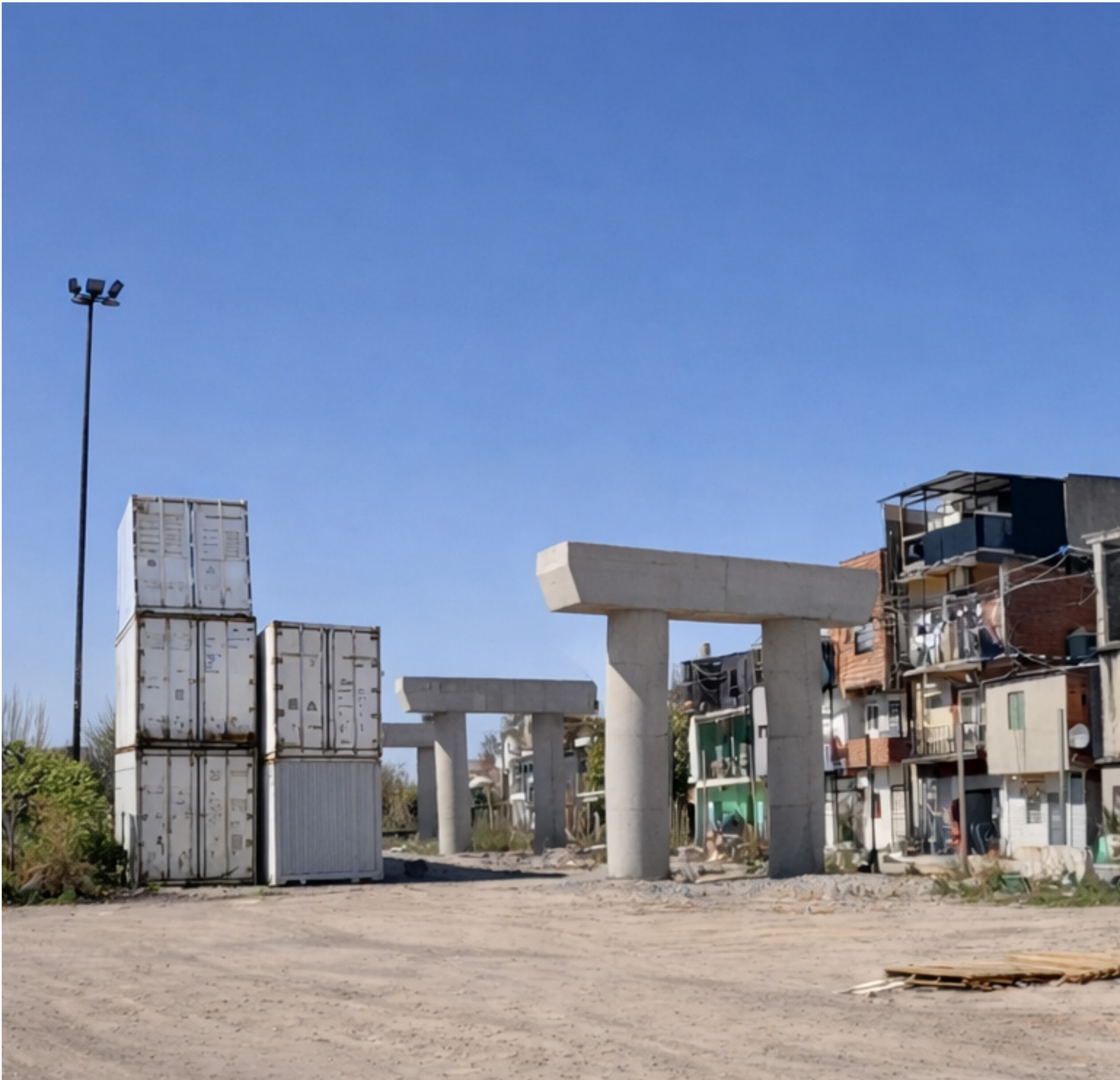
Imagen 23: Villa 21-24, Buenos Aires, Argentina. Vista peatonal de los pilares de la obra inconclusa del Viaducto Belgrano Sur y su relación de proximidad crítica con las viviendas del barrio. PMK Drones, 2024. Fuente: PMK Drones, Viaducto Belgrano Sur - Obra Inconclusa (Buenos Aires: PMK Drones, 2024).
