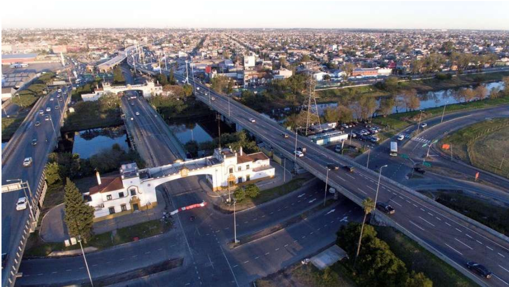
FIGURA 2: Estado de obras de ampliación Puente la Noria año 2018, CABA.
