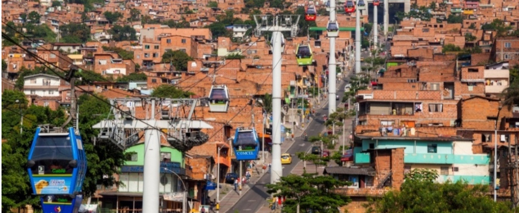
FIGURA 23: Vista aérea Línea J Metrocable
