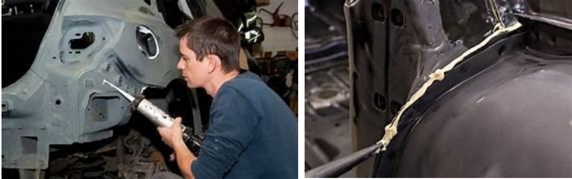
Figura 35: Aplicación de Sealer.
