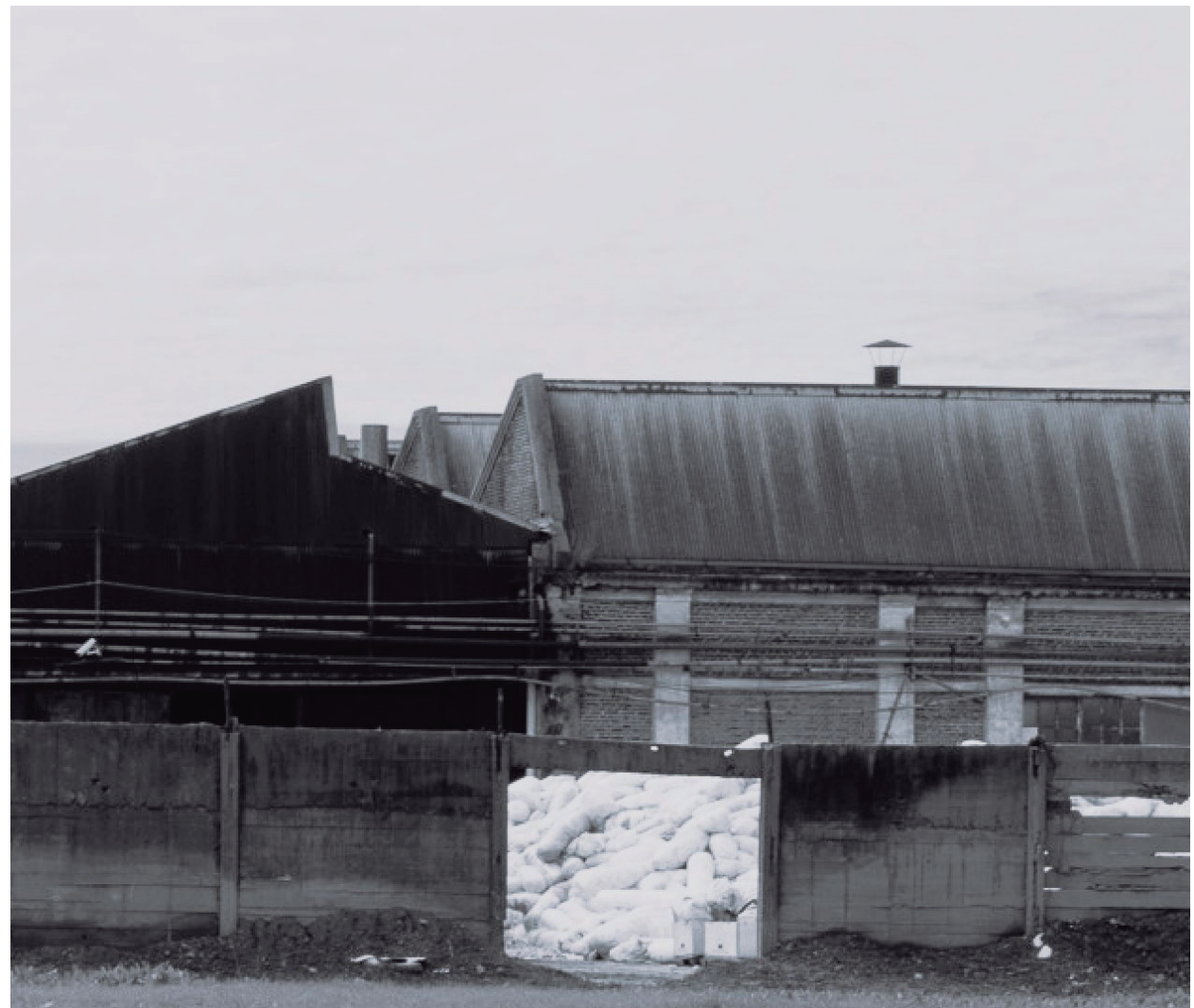
(1) Close up nave industrial a intervenir (2) Imágen propia de la nave industrial a intervenir
