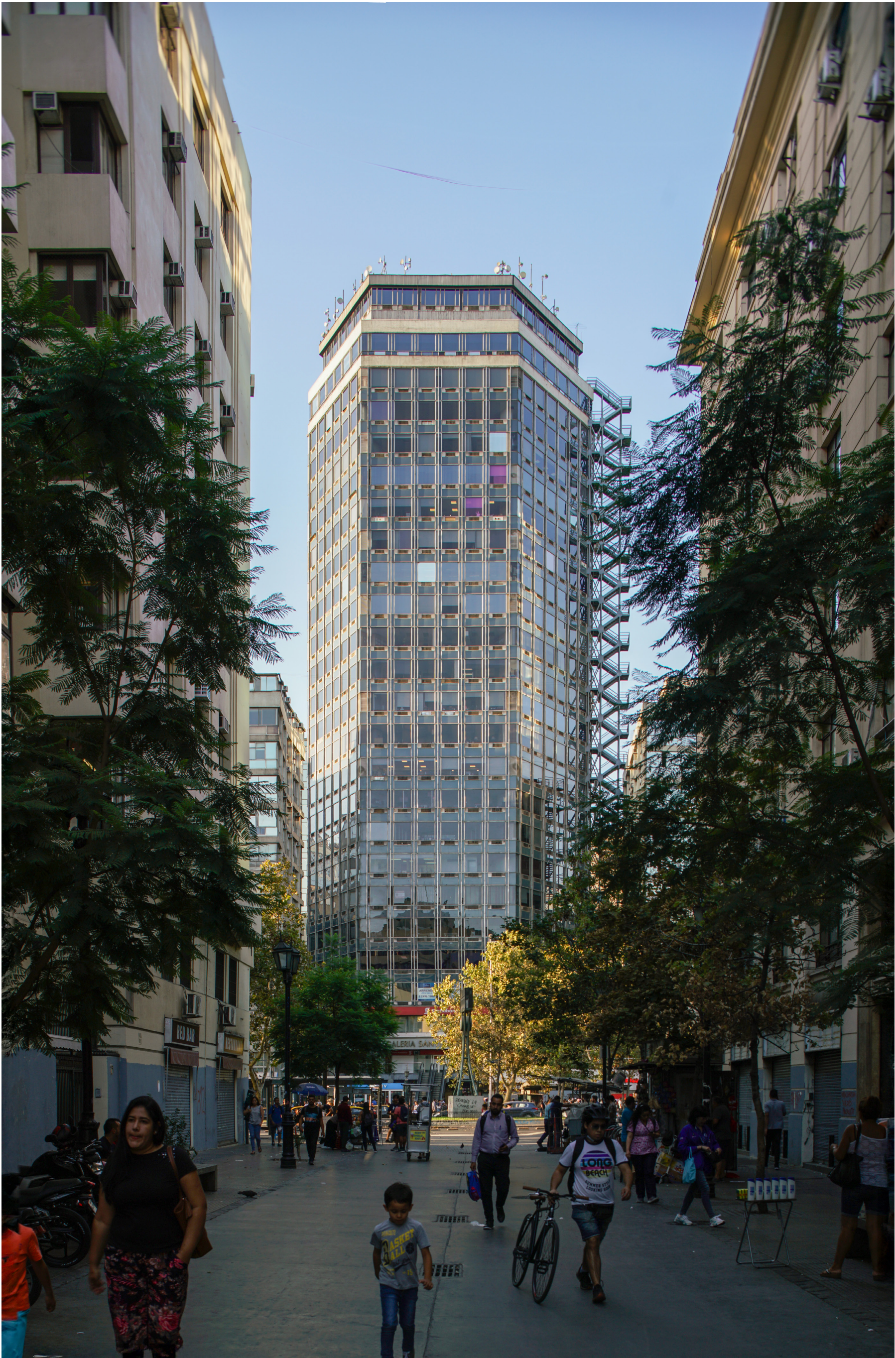
Imagen: Fotografía. Vista frontal desde calle Serrano. Edificio Santiago Centro.
