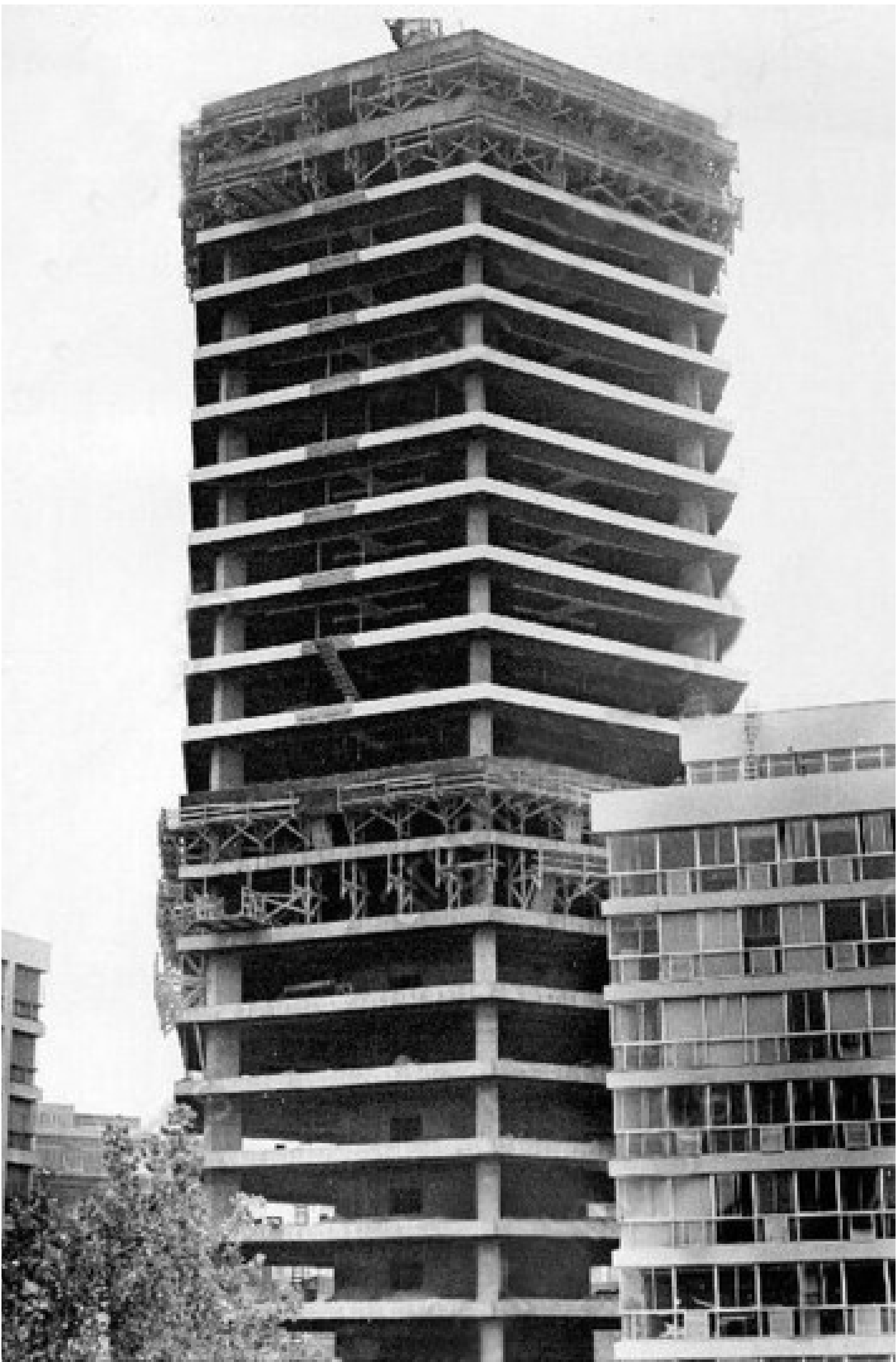
Imagen: Fotografía. El Santiago Centro en construcción. Se aprecia la estructura del bloque B, 1969-1972.
