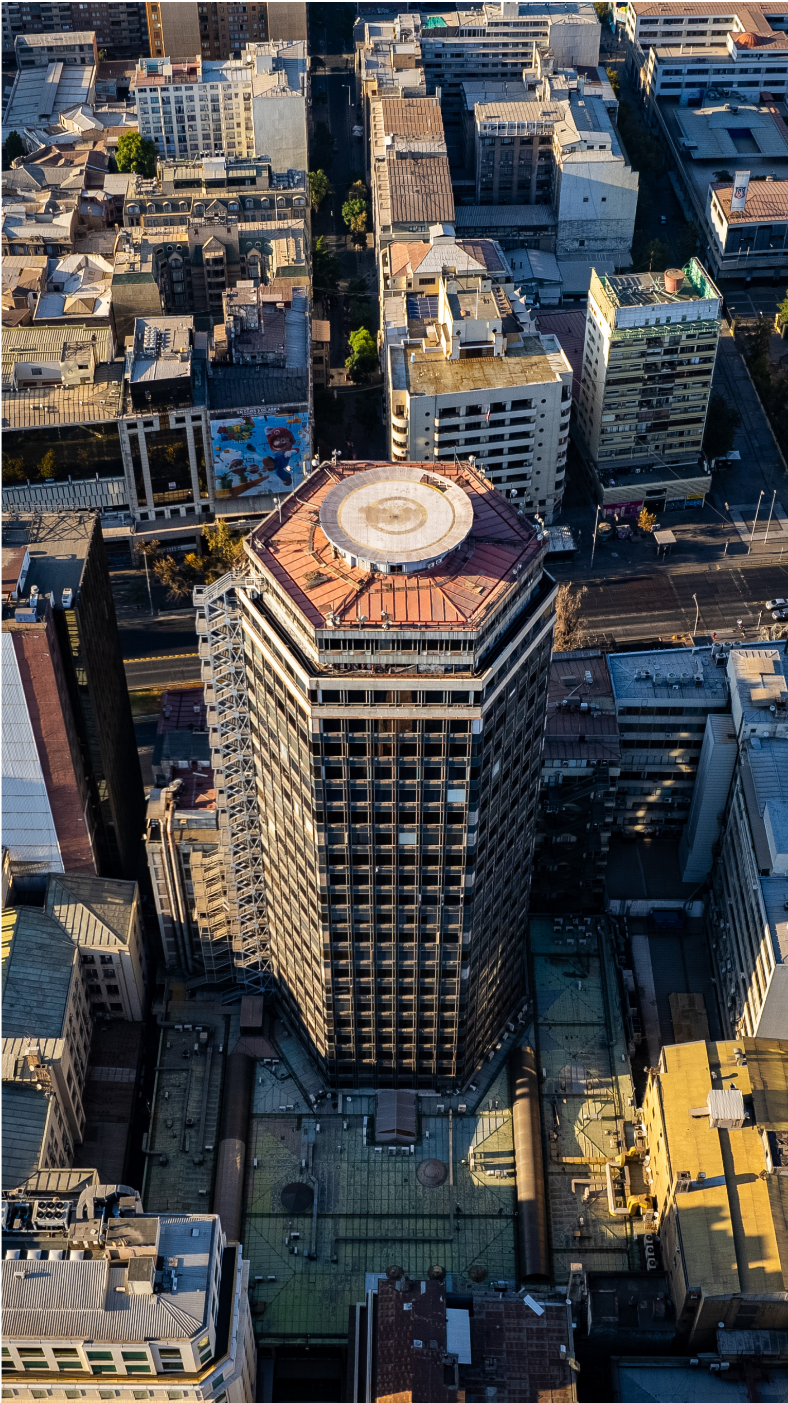
Imagen: Fotografía. Vista aérea de cubierta.
