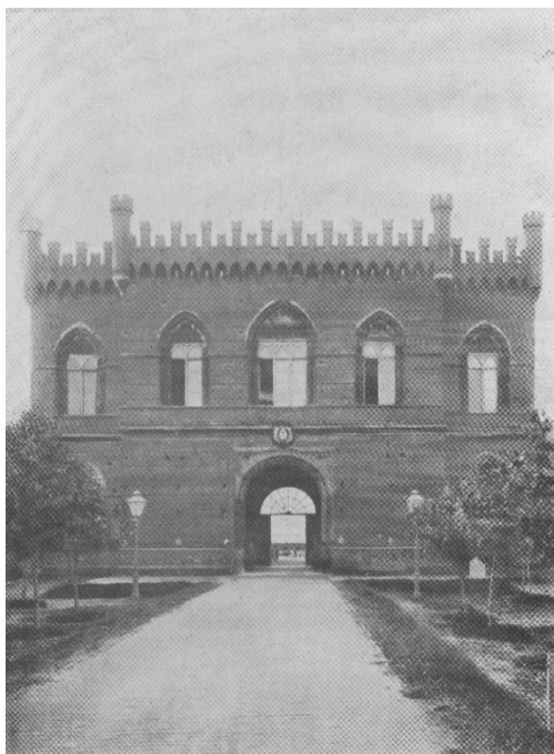
Fig. 88: Cuartel de Caballería Maldonado demolido en 1889. Fuente: Revista El Suboficial, 1926.
