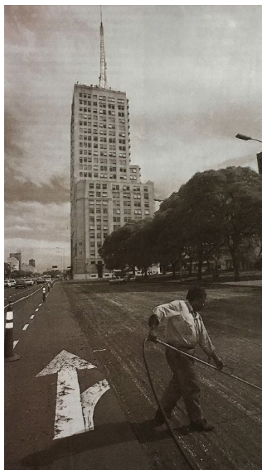
Fig. 78: Edificio del Ministerio de Obras Públicas. Alberto Belgrano Blanco. MOP 1934. Fuente: Anahí Ballent y Graciela Silvestri. “Ministerio de Obras Públicas” en Diccionario de Arquitectura en la Argentina , dir. Fernando Aliata y Francisco Liernur, (Buenos Aires: AGEA, 2004)
