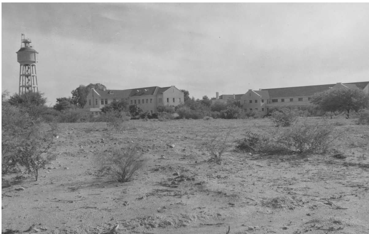
Fig. 60: Cuadras de tropa modelo 1934 en el cuartel de La Rioja. Dirección General de Ingenieros, Cuartel de la Rioja, 1934. Fuente: AR_AGN_DDF/ Consulta_INV: 79239.
