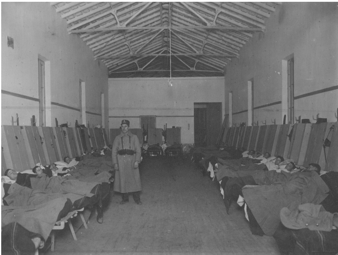
Fig. 41: Interior de cuadra de tropa, 1912. Fuente: AR_AGN_DDF/ Consulta_INV: 161697.
