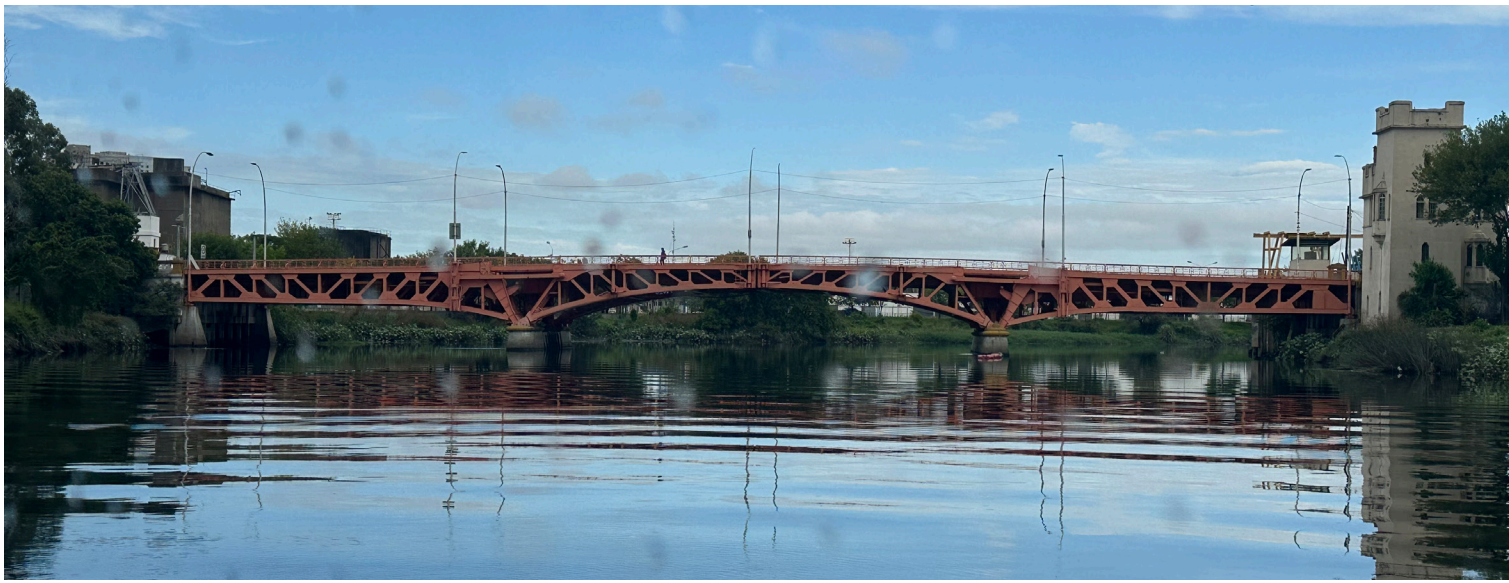
Viejo Puente Pueyrredón. Imagen 29 - propia
