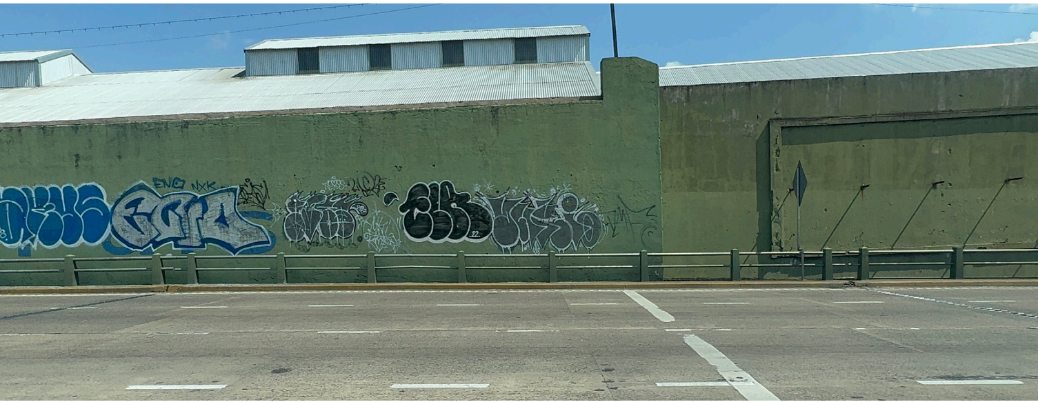
Fachada industrial en el recorrido de la Autopista Arturo Frondizi. Imagen 28 - propia
