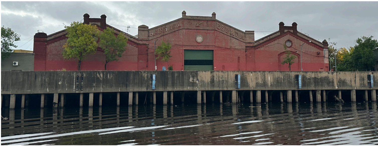
Infraestructura anti- inundación. Imagen 27 - propia
