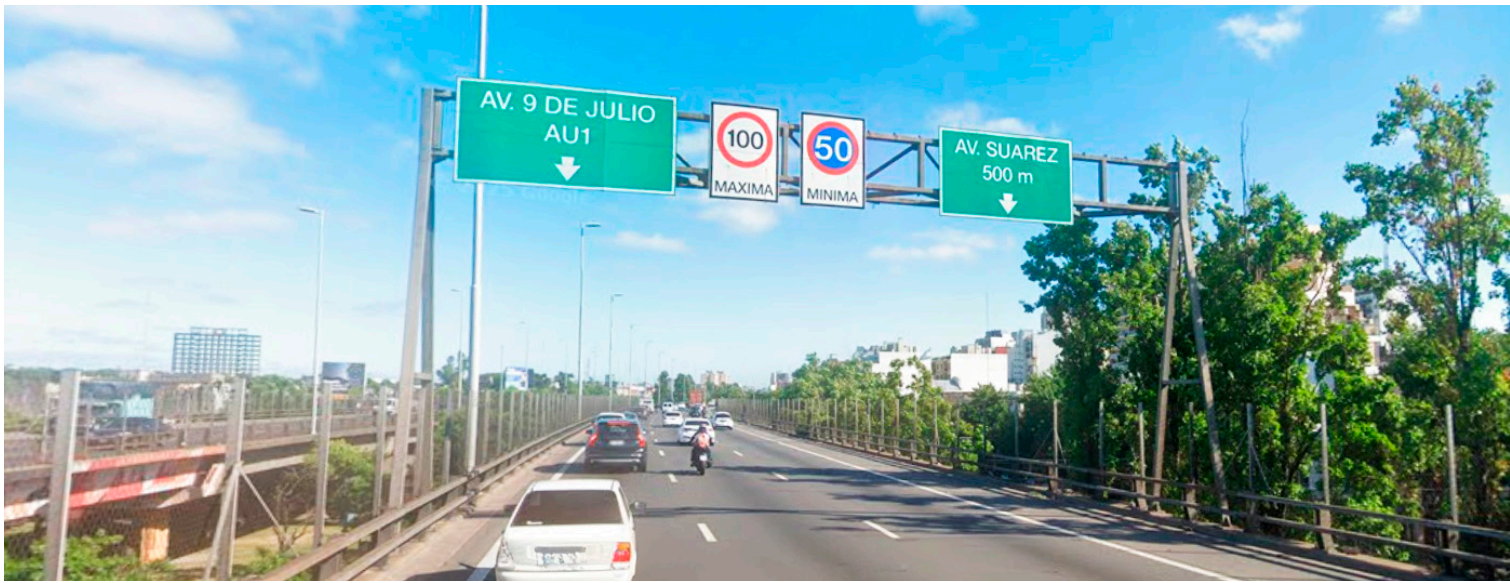
Autopista Arturo Frondizi. Imagen 22 - propia
