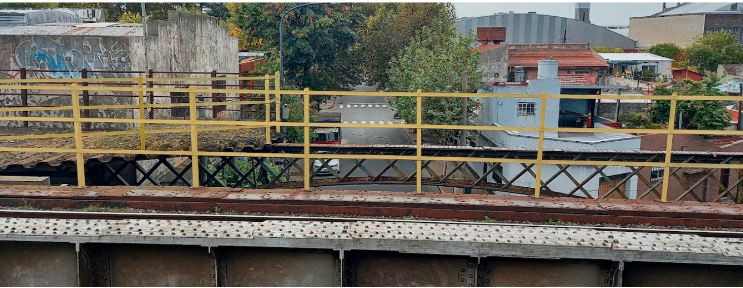
Estación Hipólito Yrigoyen. Imagen 30 - propia
