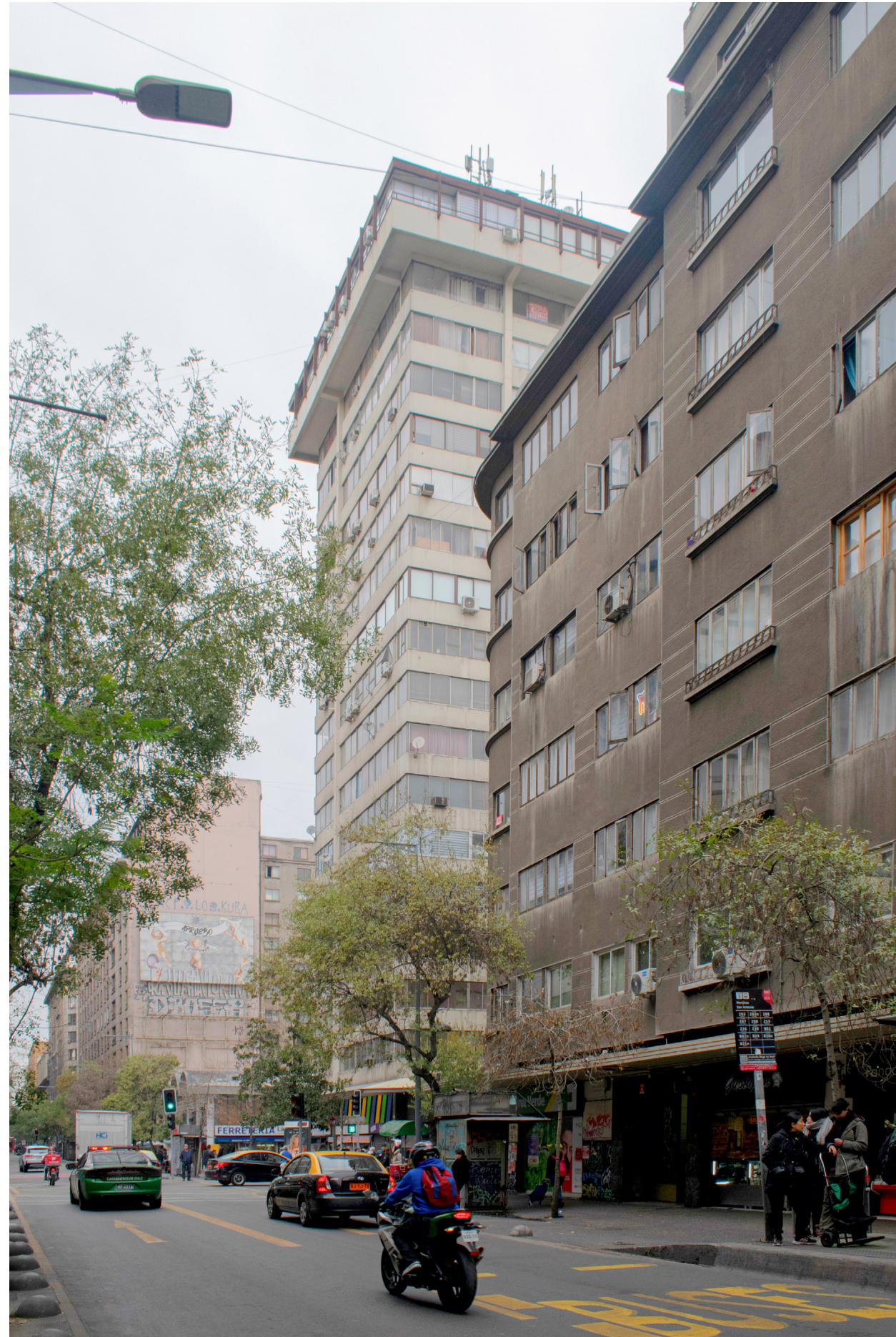
Fig. 67. Fotografía desde la calle San Antonio donde se puede notar la totalidad de la torre así como su entorno inmediato. Elaboración propia
