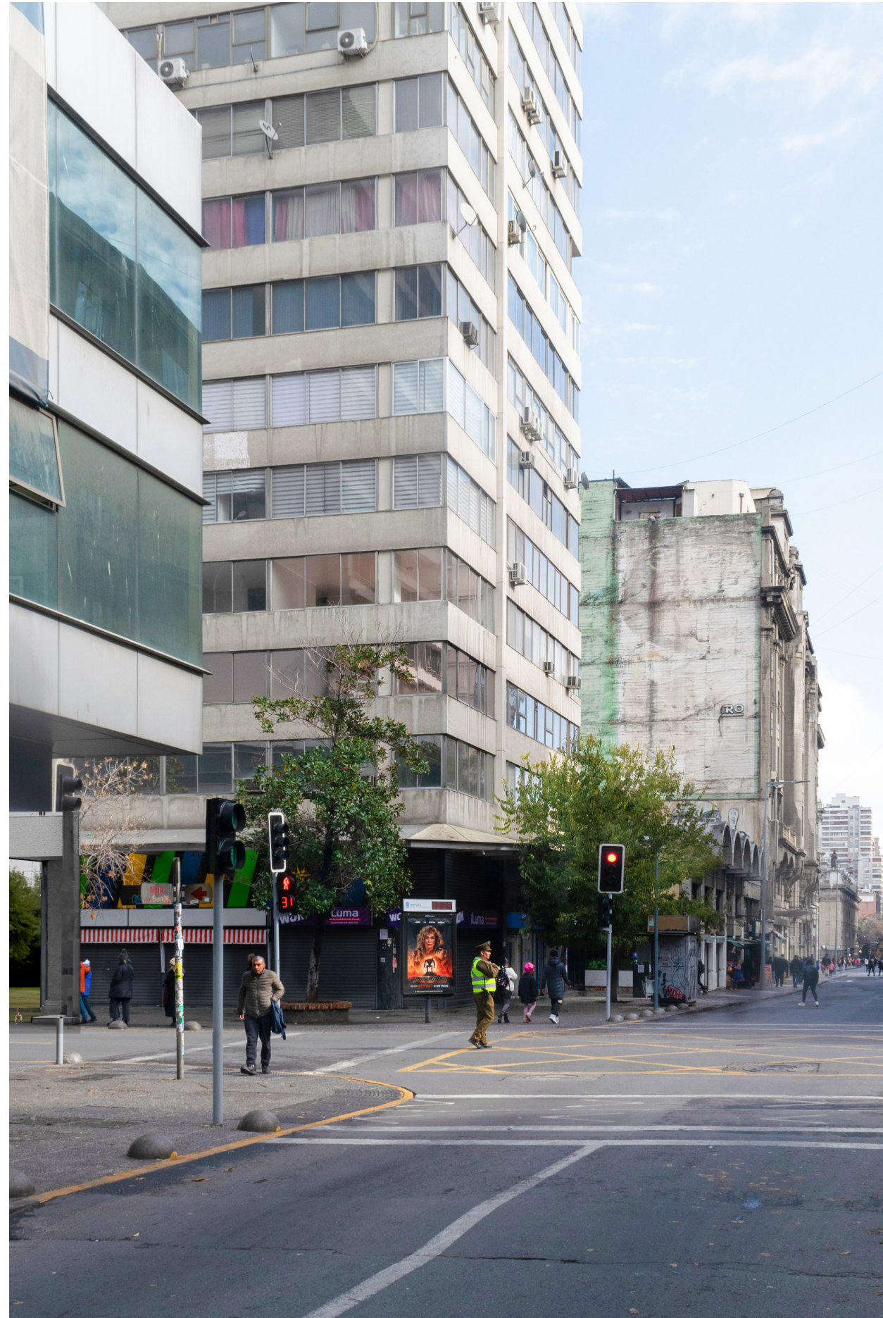
Fig. 69. Fotografía desde la calle Monjitas donde se busca relacionar parte de la torre con el edificio lindero, mostrando el estado actual de las medianeras. Elaboración propia
