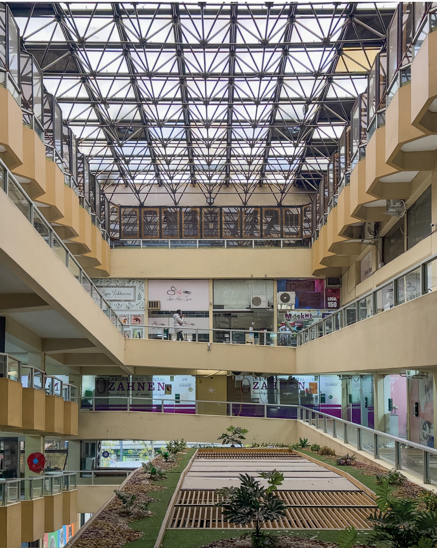
A medida que la galería comercial asciende por los distintos niveles del basamento, se observa una transformación en el tipo de locales y en la actividad. En todo el basamento comercial, que cuenta con capacidad para 186 locales, la ocupación ha disminuido hasta en un 30%.
