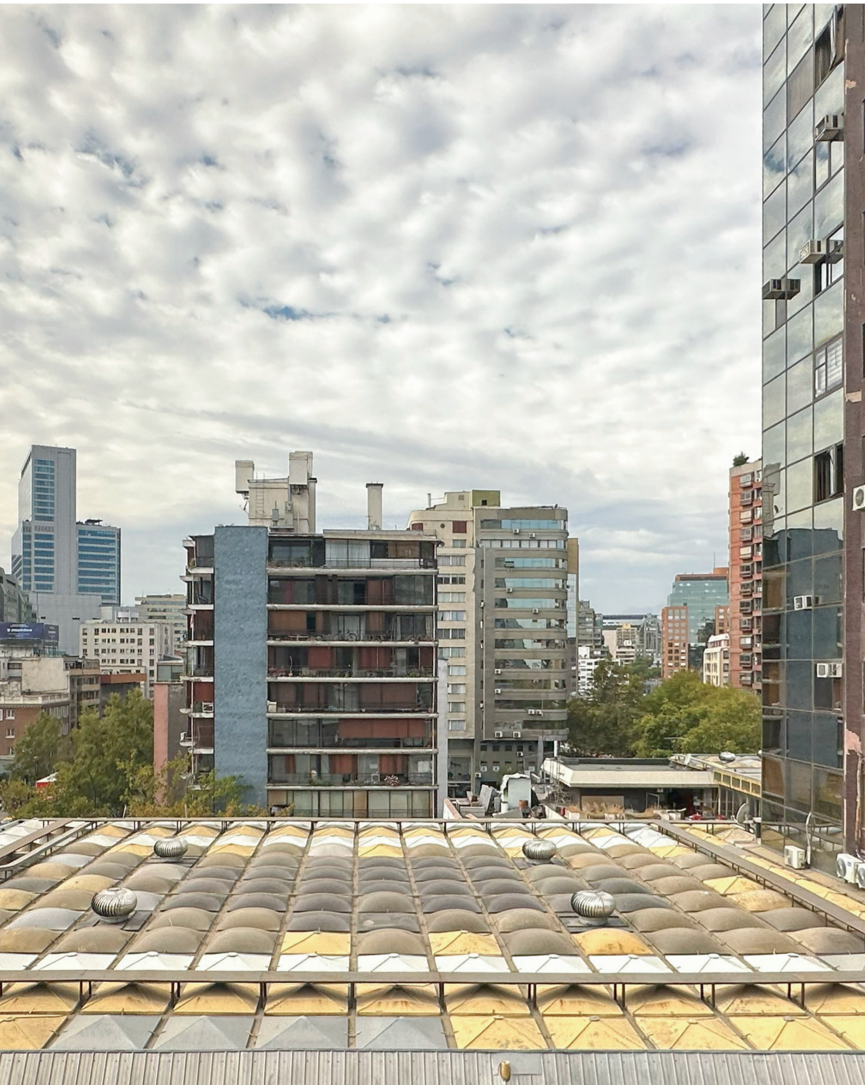
Imagen terraza Edificio Giratorio
