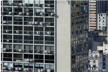
ESTADO ACTUAL FACHADA SUR Y ESTE
