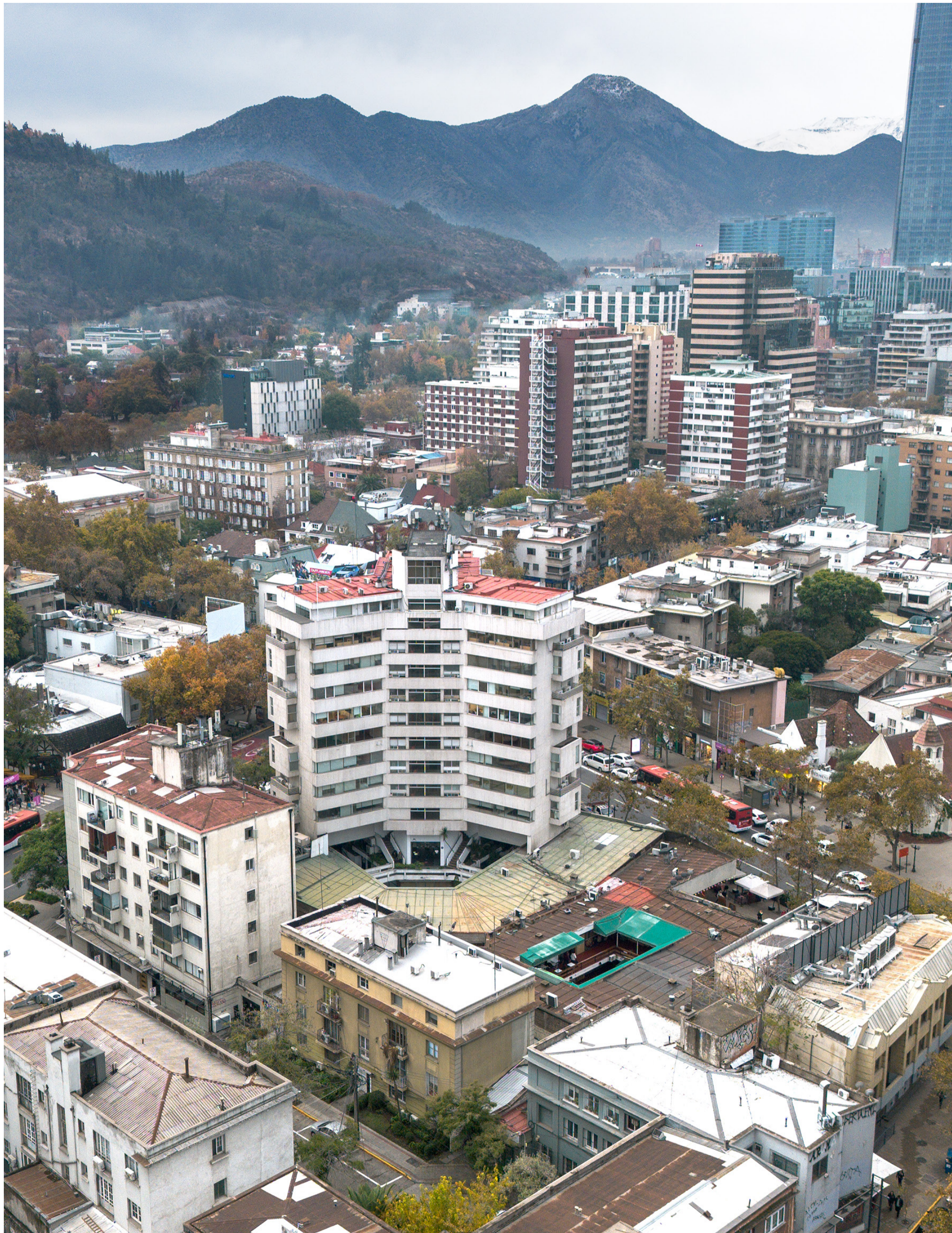
fotografía aérea desde av. nueva providencia.Mayo 2024.
