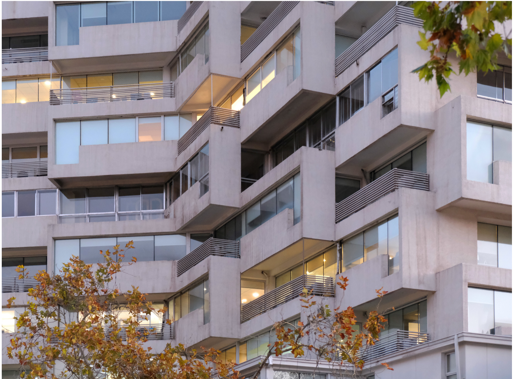
fotografía fachada edificio original. Mayo 2024.
