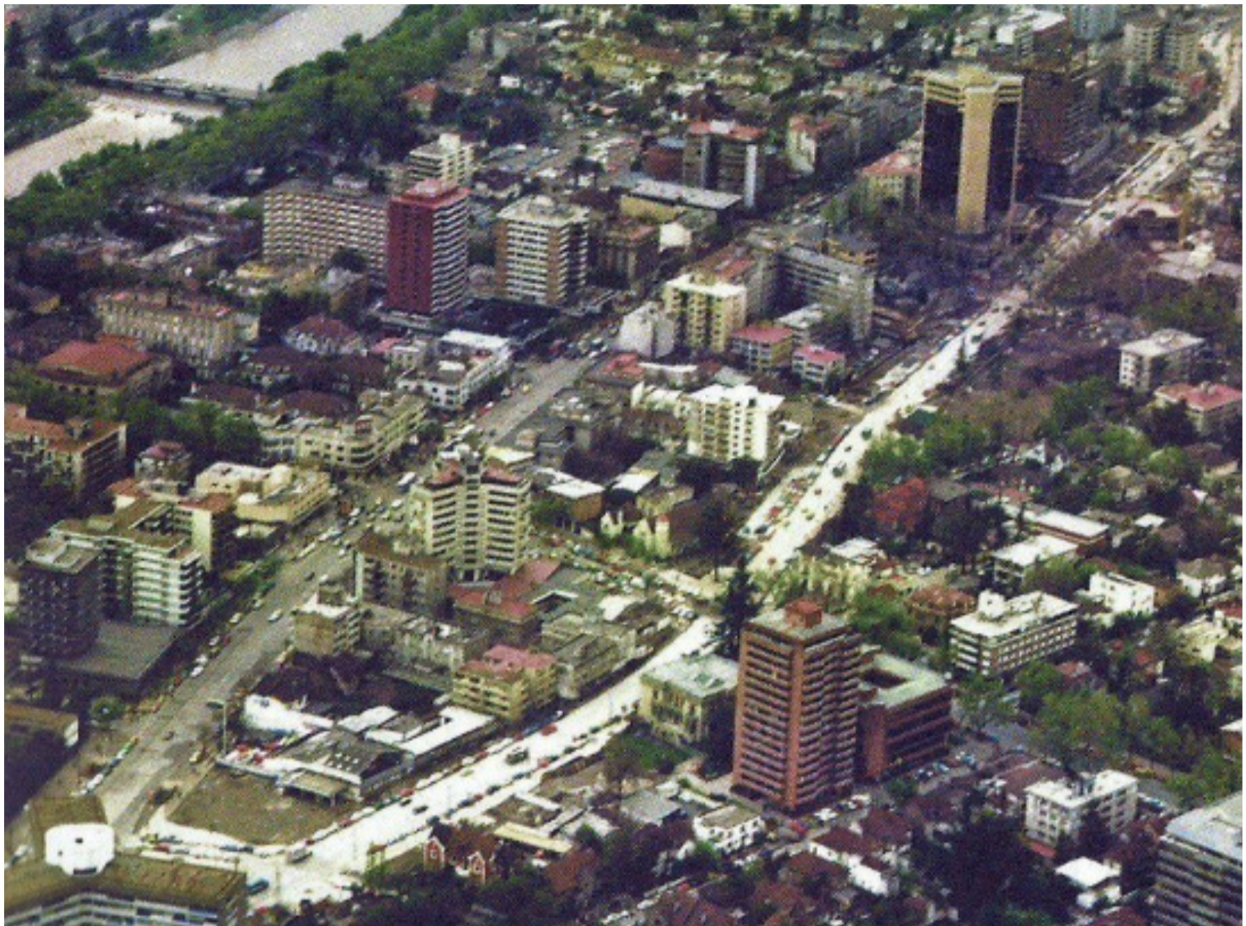
05. Providencia, Fotografía aérea de avenida providencia y avenida nueva providencia. 1980.
