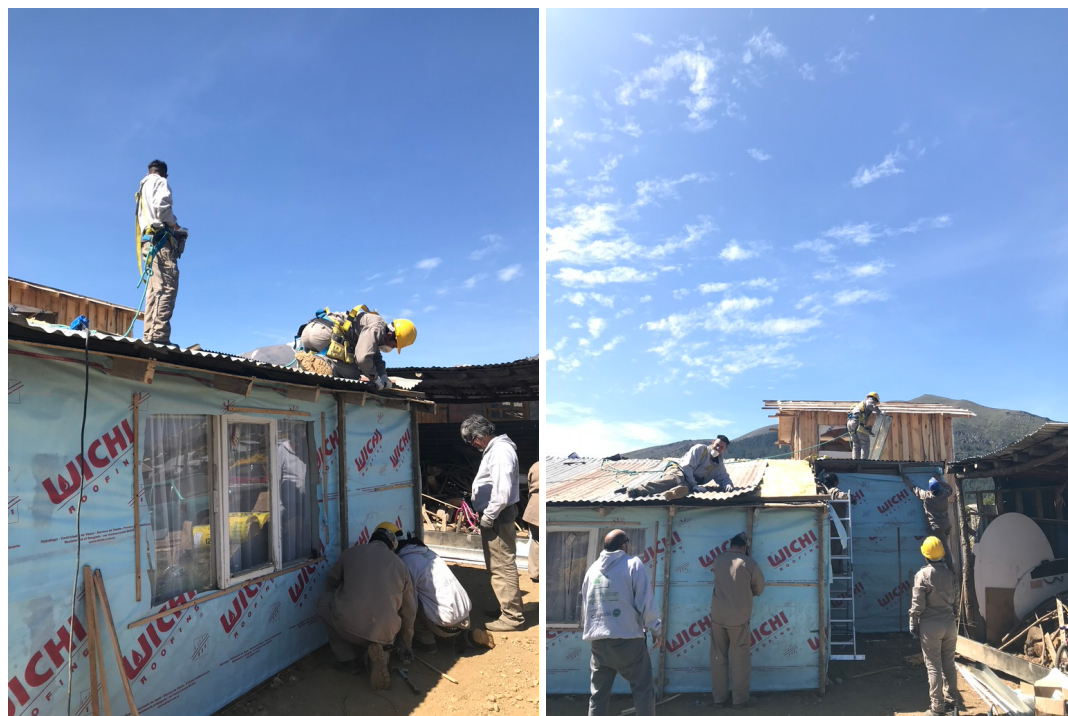
Imagen 8: Obra de mejoramiento en una Vivienda de Bariloche. Programa Sustentabilizar Hogares
