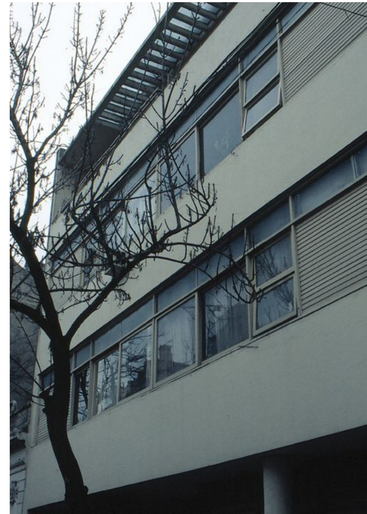
Fotografía exterior. Sector de fachada frente a la calle Humberto Primo. Fuente: PIÑÓN, Helio. Mario Roberto Álvarez y Asociados . Universitat Politècnica de Catalunya, Talleres Gràfics Hostench. Barcelona 2002. CD
