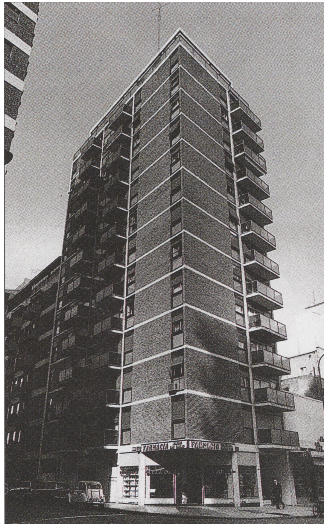
Fotografía exterior. Esquina de la calle Yapeyú y la avenida Rivadavia. Fuente: MARIO ROBERTO ÁLVAREZ Y ASOCIADOS. Obras 1937/1993 . Morgan Internacional. Santiago de Chile 1993. Página 68
