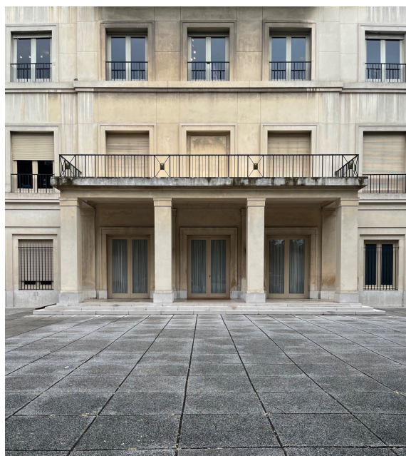
82. Palacio Devoto. Vista desde el Cour d'honneur al pórtico de ingreso
