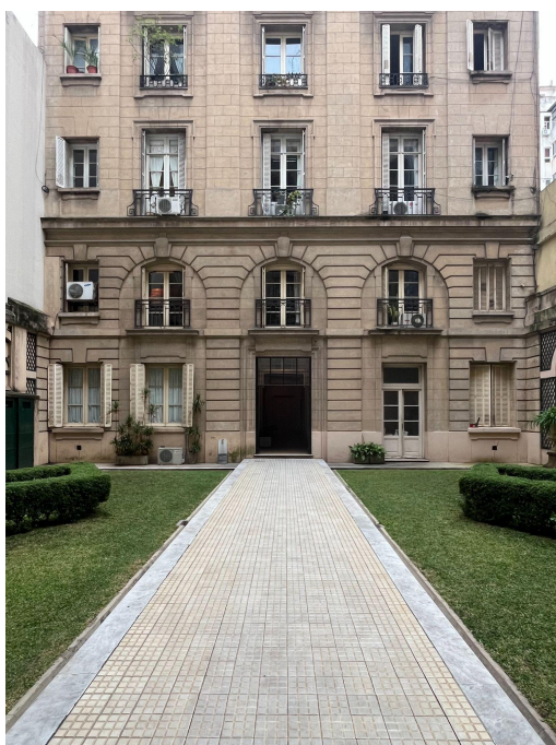
104. Patio interno, Lavalle 1447, 1924.
