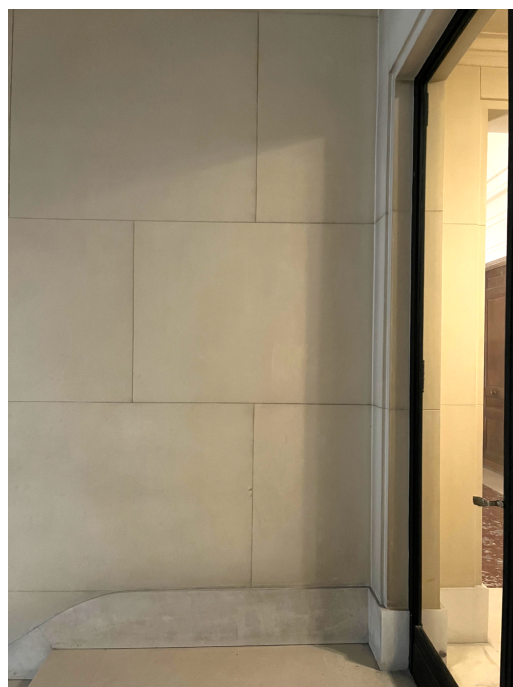
93. Revoque pétreo símil sillería en escalera.
