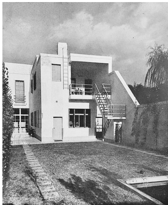
44. Casa Gómez Piñeiro, vista desde el patio. 1931.
