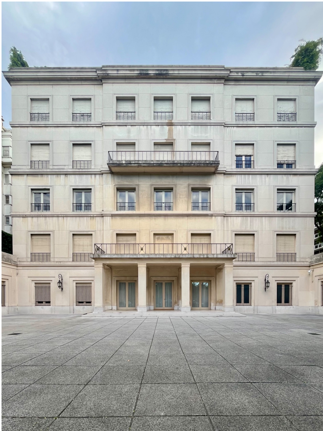
99. Fachada principal del Palacio Devoto.
