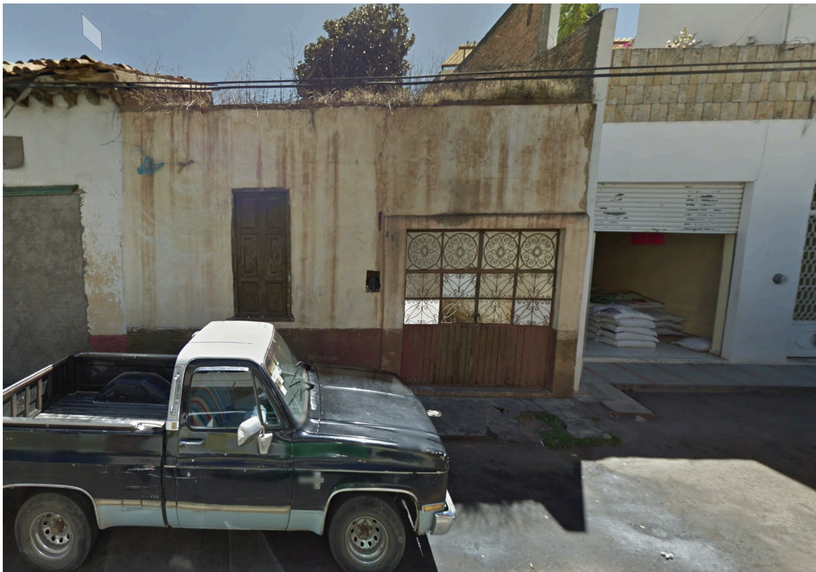
Figura 21. Av Morelos 154 sin referencias adicionales.
