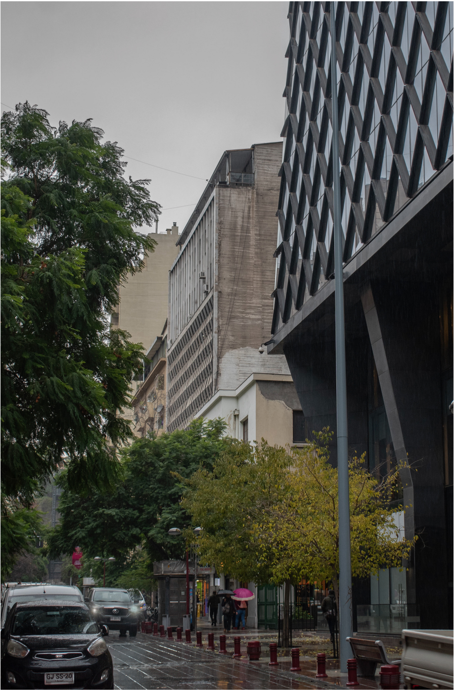
(19) Fotografía exterior del Estacionamiento Lido.
