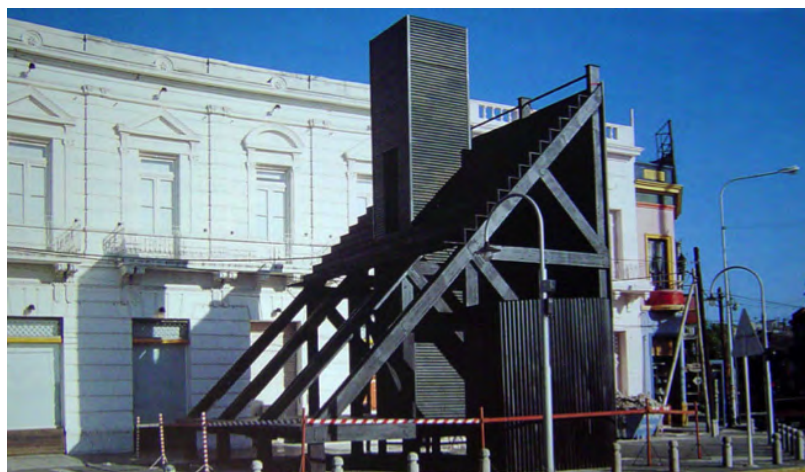
La Máscara de la medusa, Hejduk, construcción. Fuente: Fundación Proa.
