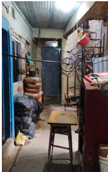
Imagen 32. Escombros en pasillo del sector 2 del Barrio Mugica.
