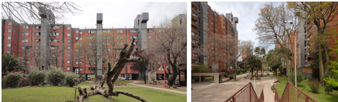
II.36. Vistas del patio interior. Archivo Unidad Permanente de Vivienda (UPV). Fotografías: Ruben Otero y Andrea Sellanes.
