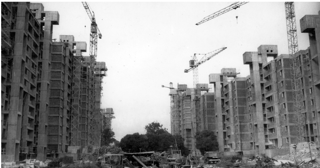
II.56. Estructura de hormigón en construcción. Archivo CCU.
