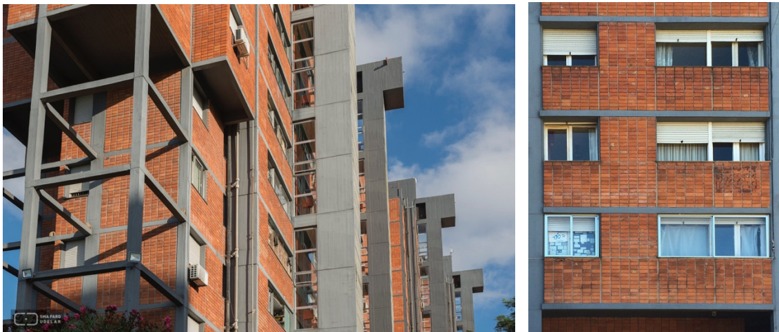
II.63. Izquierda: vista exterior. Archivo SMA, SMA-S956-024, N. Correa, 2015. Derecha: vista de la modulación del muro de ladrillo de fachada. Fotografía: Silvia Bermúdez, 2015.
