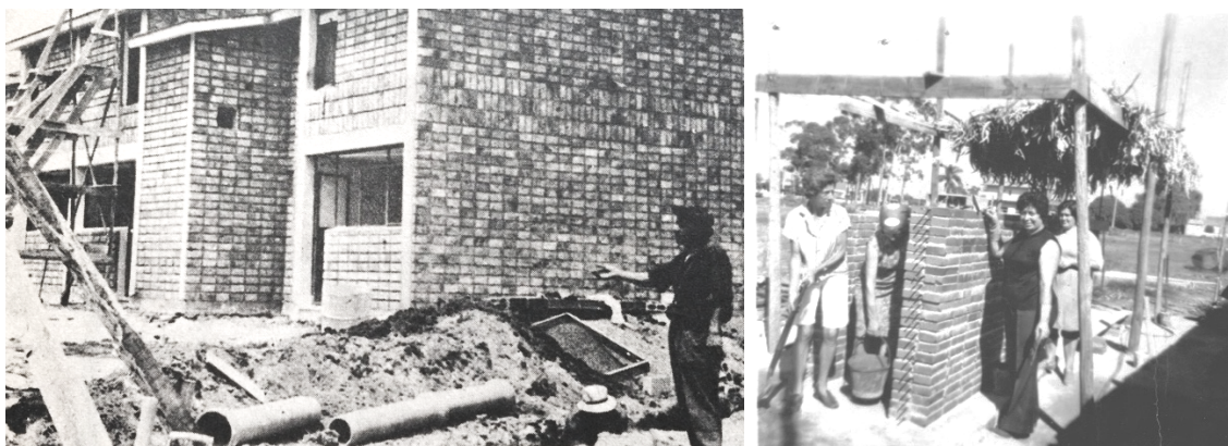
II.51. Izquierda: viviendas individuales en construcción. Derecha: cooperativistas de "ayuda mutua" posando junto a losetas prefabricadas de ladrillo producidas. Archivo particular de Norberto Cubría.
