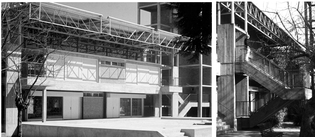
II.62. Vista de la estructura metálica de la cubierta del volumen de servicios comunitarios. Archivo CCU.
