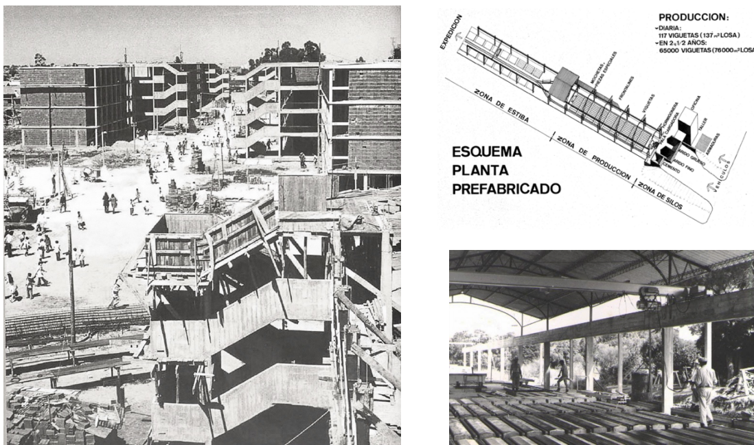
II.52. Izquierda: vista del conjunto Zona 1 en construcción. Fuente: Las cooperativas de vivienda por ayuda mutua uruguayas: Una historia con quince mil protagonistas , 1999. Derecha: Perspectiva y vista de Planta de prefabricación de losetas "u" de CEDAS. Archivo particular de Norberto Cubría.
