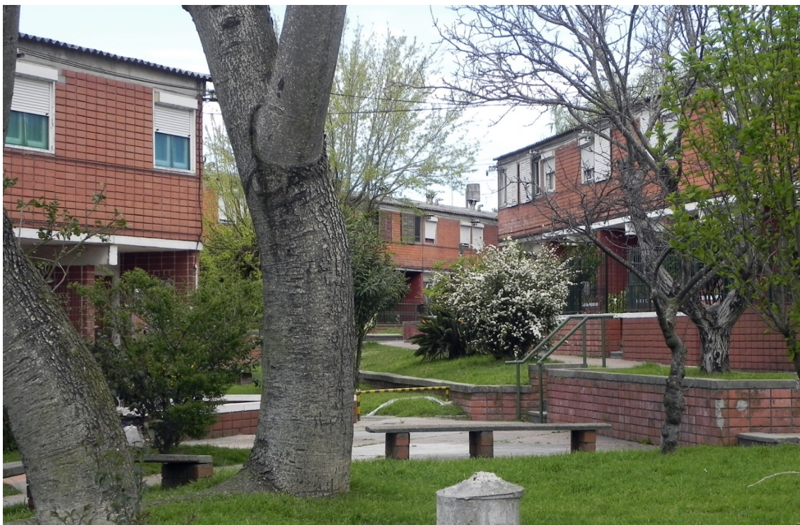
II.12. Vista desde plazoleta interna. Fotografías: Alina del Castillo, 2015.
