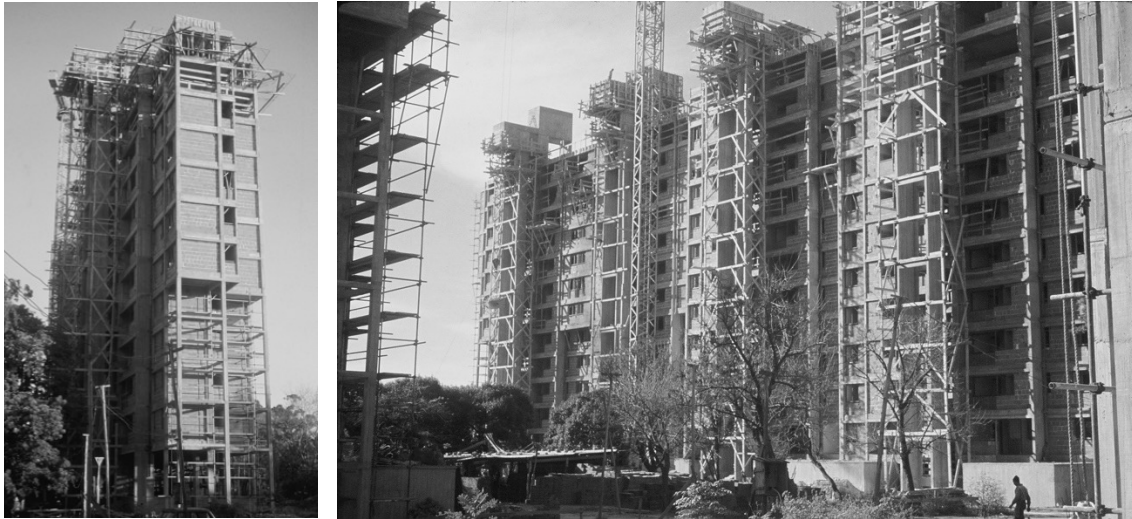
II.61. Vistas del complejo en construcción. Archivo CCU.
