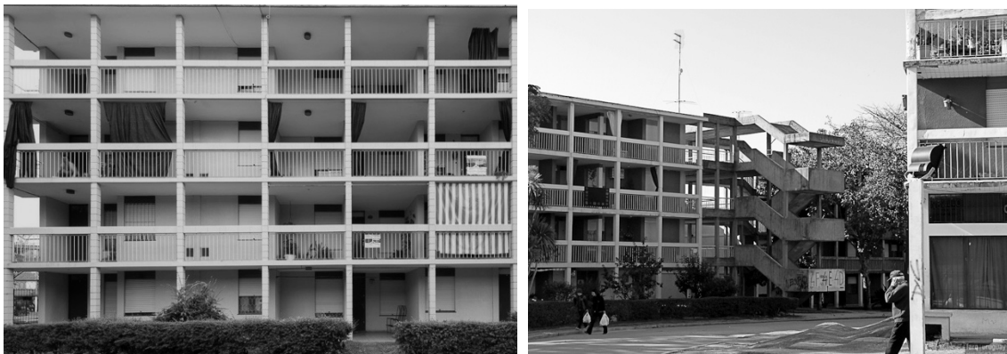
II.48. Izquierda: fachada modular de contención de calles corredor. Archivo UPV. Fotografía: Andrea Sellanes y Ruben Otero. Derecha: Vista desde los volúmenes salientes de escaleras de hormigón. Archivo SMA.
