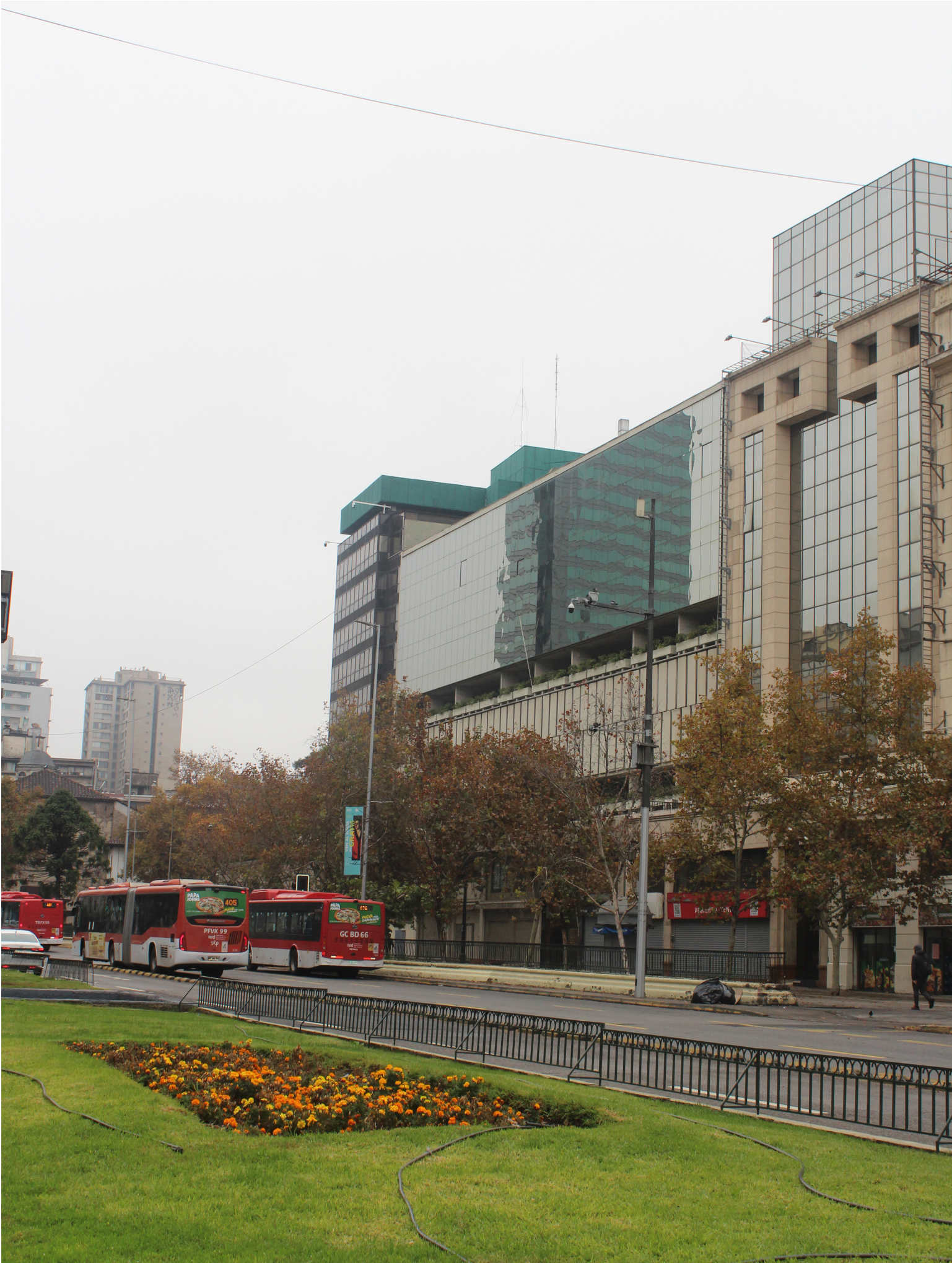
Fotografías propias de la fachada y contrafrente de nuestro edificio.
