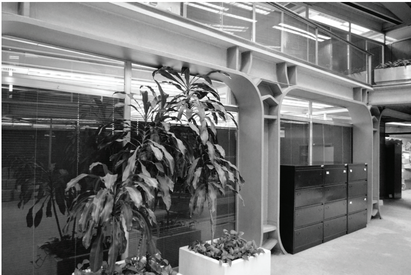
MRAyA. SOMISA. Viga “Vierendeel” en piso dúplex piso 10 con el cordón inferior embebido en la losa. Foto SP.
