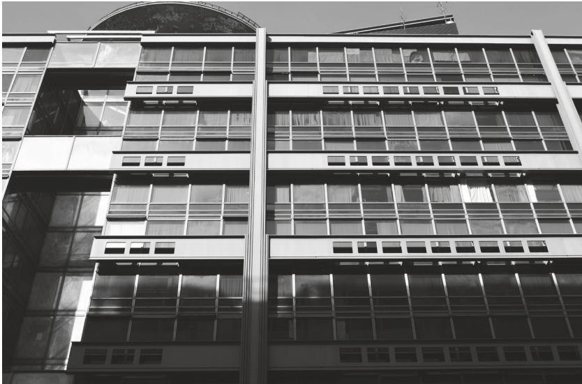
MRaYA. SOMISA. Vigas contraviento de la fachada. Foto Silvio Plotquin (SP)
