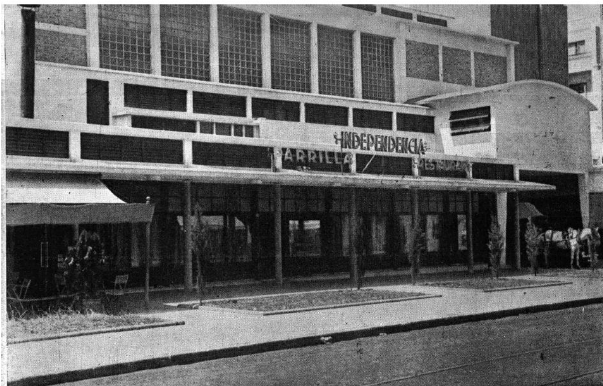
Fig. III. 9 Fachada sobre Independencia. Imagen extraída de Revista de Arquitectura , nº 295. Julio 1945
