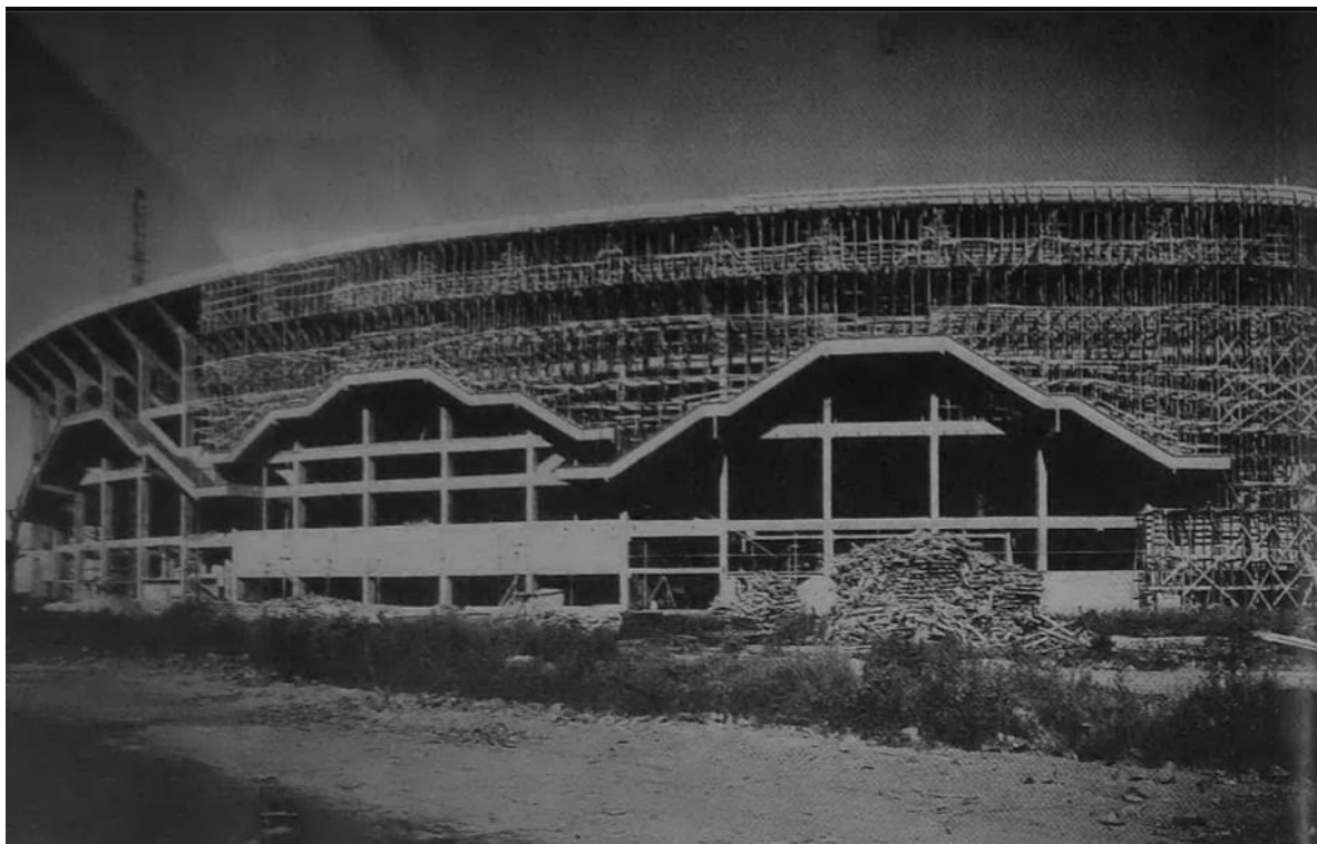
Fig. III. 34 Fotografía exterior de la construcción del estadio del Club Atlético River Plate (1938). Se puede observar gran parte del perímetro cubierto por andamiajes que forman el conjunto de encofrados que dan forma a las gradas superiores. Fuente: La Ingeniería , CAI. N° 761, marzo 1938. Buenos Aires, Argentina. 186.
