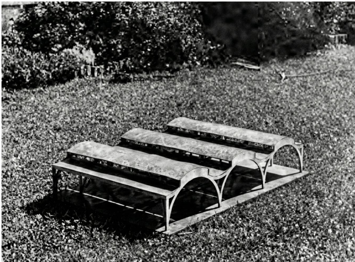
Fig. III. 27 Maqueta de cálculo del Mercado San Cristóbal, 1940. “Edificio para Mercado”, Tecné , nº3. Marzo 1944
