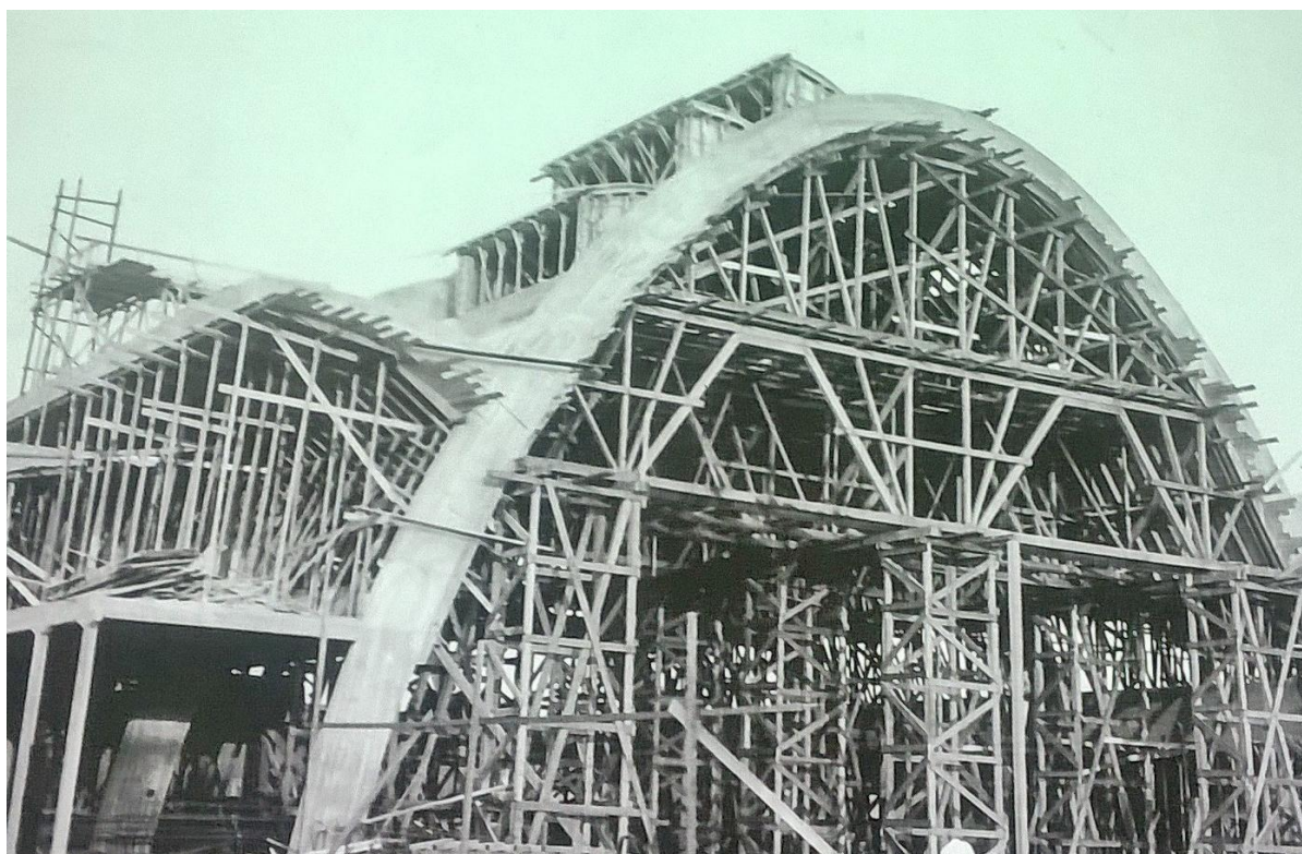
Fig. III. 30 Vista exterior de encofrados y apuntalamientos al momento de la construcción del Mercado Armonía. Fuente: Santiago Educativo, "Mercado Armonía" ca. 1932-1936.
