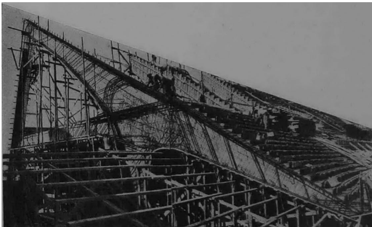
Fig. III. 36 Fotografía del encofrado y armadura de las gradas superiores del estadio del Club Atlético River Plate. Fuente: La Ingeniería , CAI. N° 761, marzo 1938. Buenos Aires, Argentina. 205.
