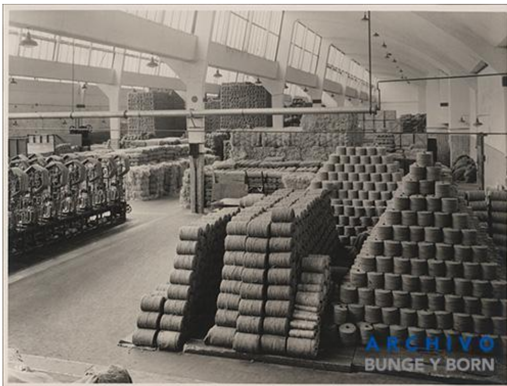
Fig. III. 25 Vista interior de la planta textil GRAFA (Grandes Fábricas Argentinas), Buenos Aires, ca. 1932-1933. Se observa el área de producción y almacenamiento de bobinas bajo una cubierta industrial caracterizada por el uso de láminas de hormigón. Fuente: "GRAFA", Archivo Fundación Bunge y Born, https://archivo.fundacionbyb.org/albumes/grafa/#bwg3/24 .
