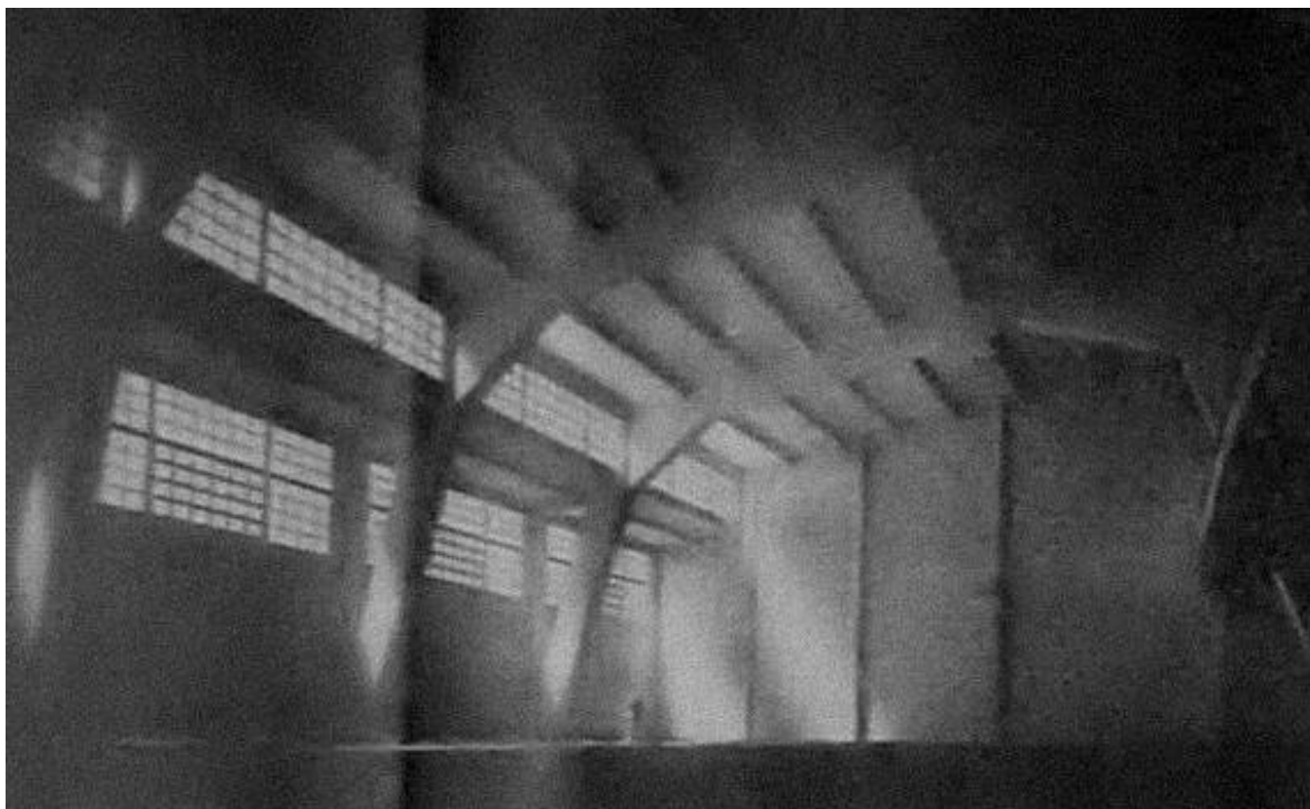
Fig. III. 35 Fotografía interior del gimnasio del Club Atlético River Plate. La estructura se conforma de pórticos "abiertos". Fuente: La Ingeniería , CAI. N° 761, marzo 1938. Buenos Aires, Argentina. 188.
