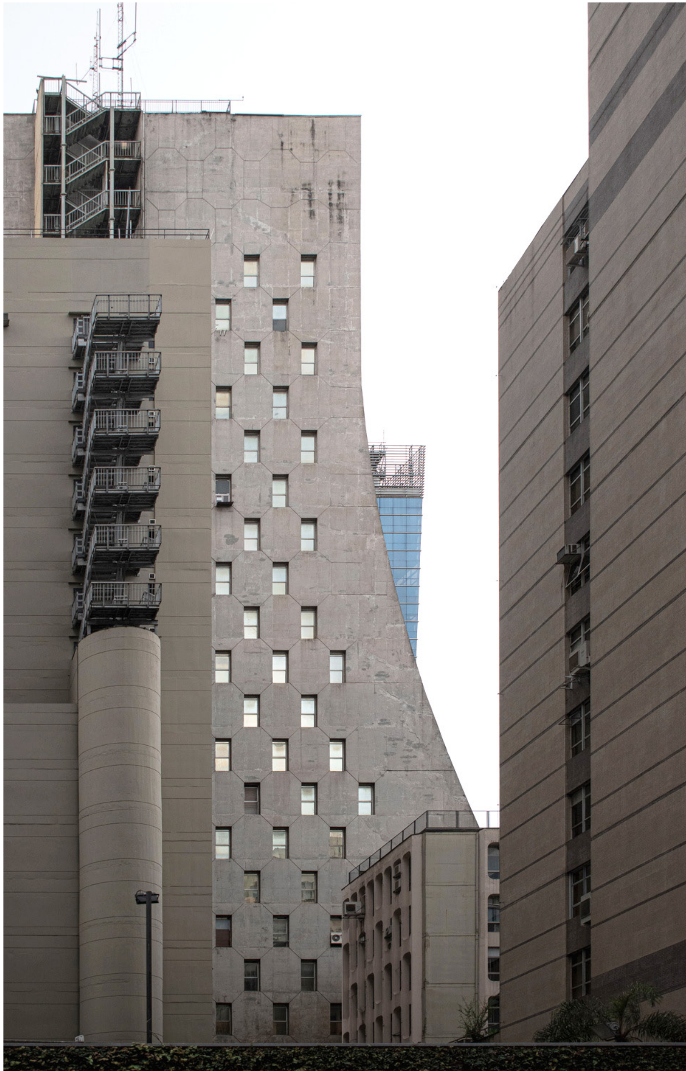
Vista Lateral desde Alameda Campinas, São Paulo, Brazil, 2023
