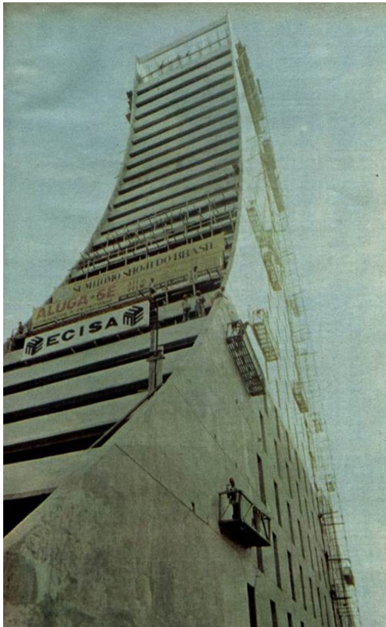
Img. 19. Construcción del edificio, São Paulo, Brazil, 1973
