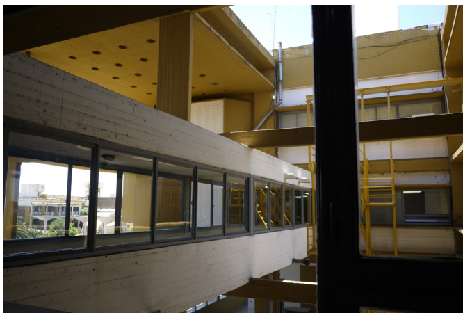
Fig. III. 28 Extremo oeste de la fachada norte. En la fotografía se observa el vacío estructural que toma la altura total del edificio. Se identifica también el acceso peatonal que permitía el ingreso por este extremo invitando a un recorrido de las galerías laterales, hoy día suprimido. Por sobre éste, al nivel de la gobernación, una losa se proyecta desde la gobernación hasta la fachada occidental. (Fuente: Archivo personal Arq. Onofre Sacco)
