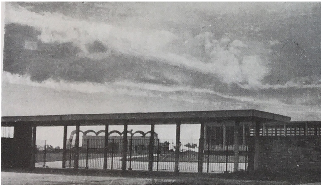
Fig. III. 2 F. Rossi, DGA-DGCT, Estación Radiodifusora «Gral. Pacheco», provincia de Buenos Aires, 1950. Pabellón de guardia. En el fondo, a la derecha el edificio de telecomunicación y, a la izquierda, la Usina
