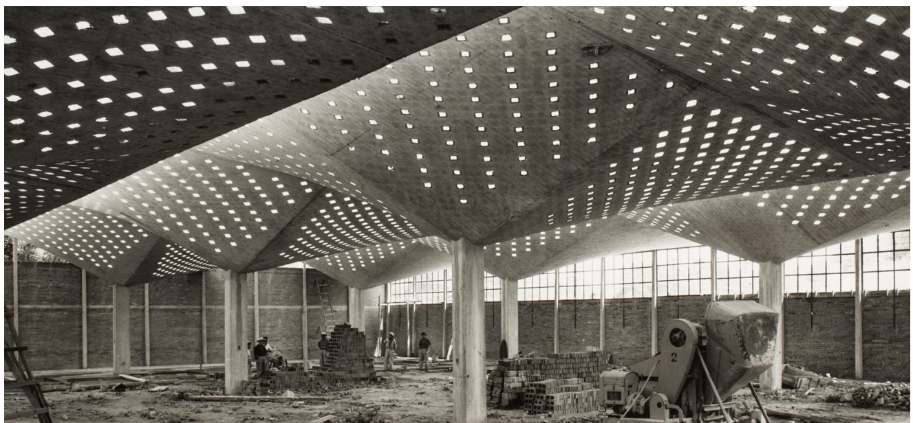
Cubiertas compuestas por secciones de paraboloides hiperbólicos
