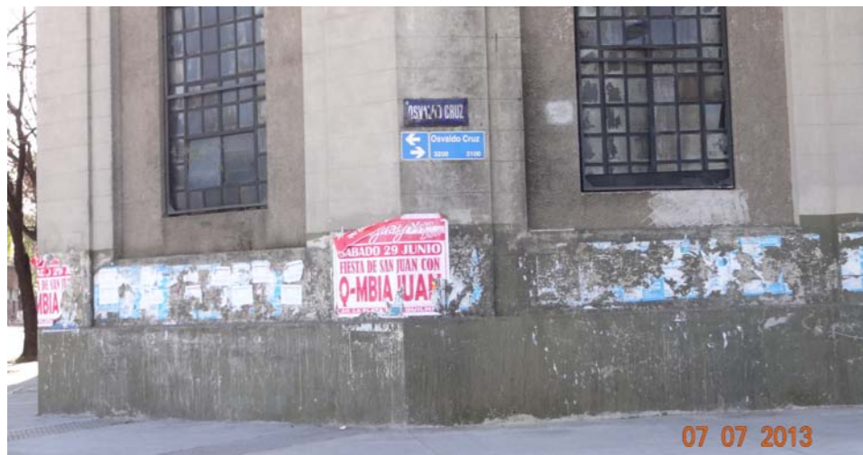
Fábricas en desuso aledañas (futura 1ª etapa).
