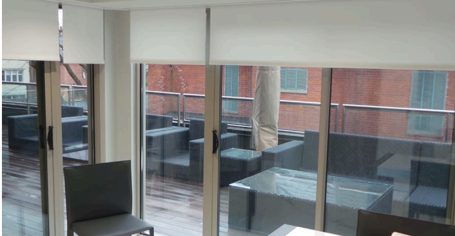
Figura 5: Persianas y cortinas automatizadas para optimizar iluminación y calefacción
