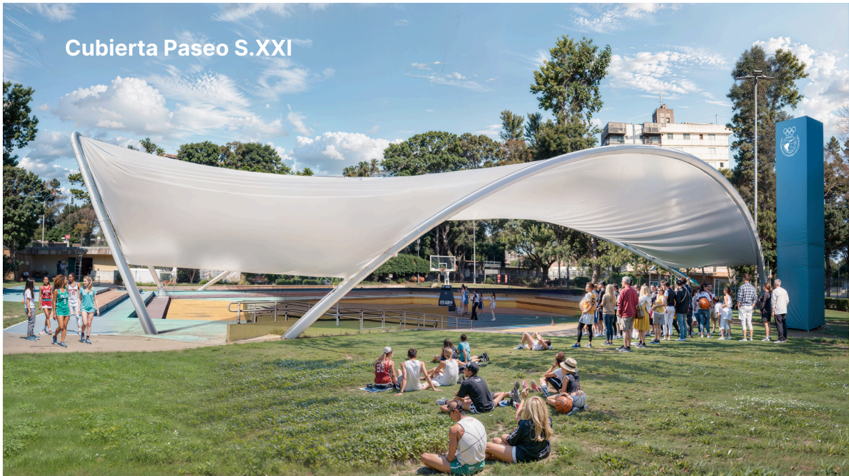
Figura 26 Cubierta Paseo SXXI
